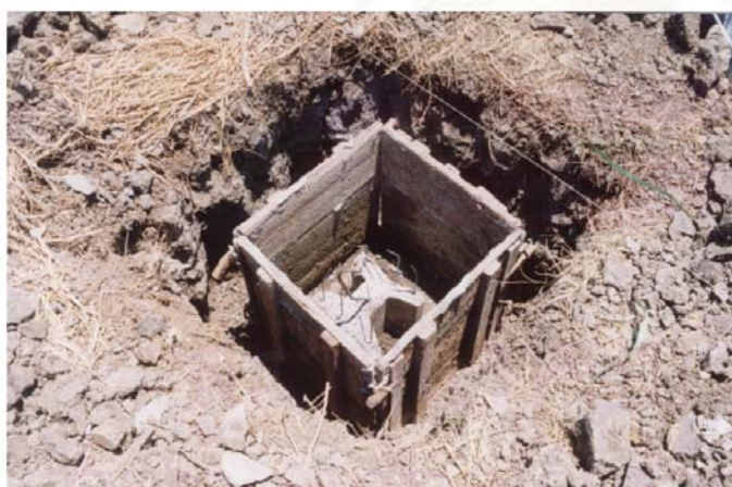
ก. การทำไม้แบบหล่อฐานราก
