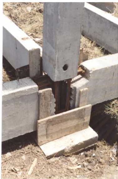
รูปที่ 5-52 แสดงรูที่ใช้ในการกรอกคอนกรีตลงในไม้แบบ และการเทคอนกรีตโดยใช้การตักคอนกรีตมาเท
