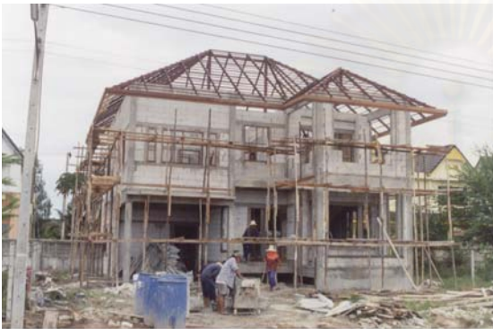
ญ. แสดงการติดตั้งเชิงชายและก่อผนัง เพิ่มเติม ( เก็บรายละเอียดงานในช่วงเวลาดังกล่าว )
