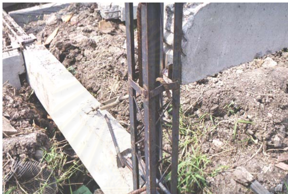
รูปที่ 5-75 แสดงการขอกเกี่ยวแขวนคานกับส่วน Cleat ที่เสา ทำให้เสาในส่วนนั้นงอและเสียรูปไป
