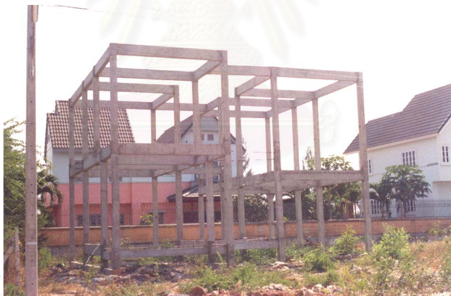
รูปที่ 5-56 . แสดงการโครงสร้างทั้งอาคารที่ประกอบขึ้นส่วนเสร็จสิ้น (เฉพาะส่วนงานโครงสร้างของซีคอน)
