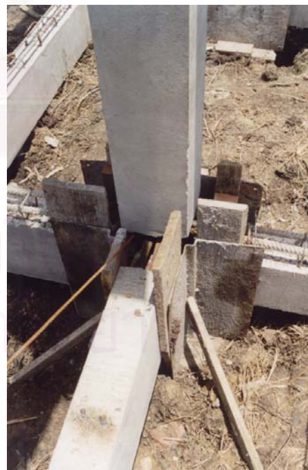
ข. ไม้แบบบริเวณที่ไม่สามารถใส่ไม้แบบเหล็กได้
