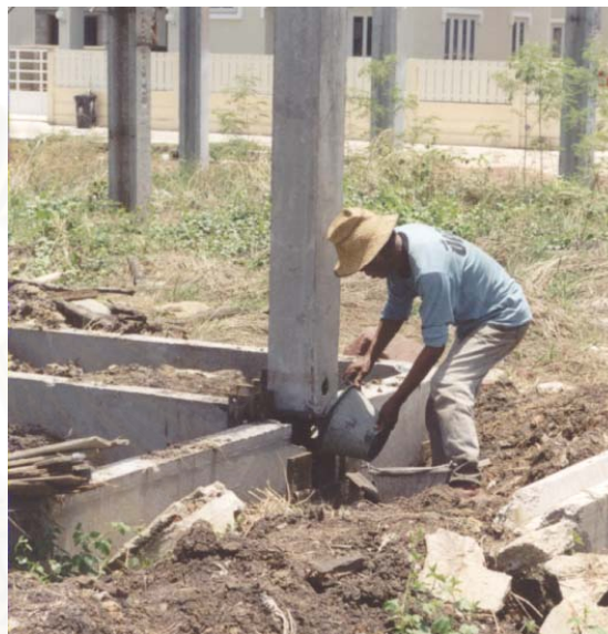
รูปที่ 5-52 แสดงรูที่ใช้ในการกรอกคอนกรีตลงในไม้แบบ และการเทคอนกรีตโดยใช้การตักคอนกรีตมาเท
