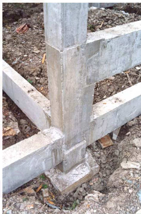
ข. แสดงรอยต่อที่เกิดจากการหล่อแบบ 2 ครั้ง
