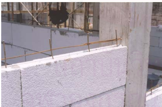
ก. การใส่เหล็กหนดกึ่งเพื่อทำคานทับหลัง
