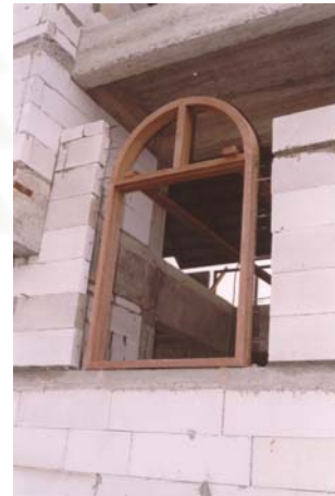
รูปที่ 5-82 แสดงการทำคานทับหลังและการทำวงกบประตู-หน้าต่างที่ไม่ได้มาตรฐาน
