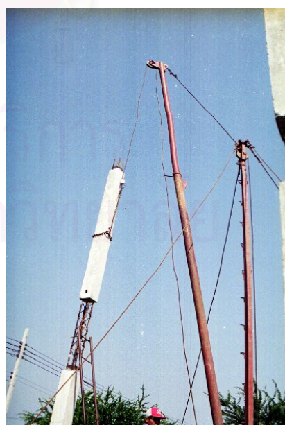
รูปที่ 5-41 แสดงการยกเสาโดยใช้ Guy Derrick cranes ผู้ใกล้ชิดกับส่วนลำตัวเสา แล้ว
