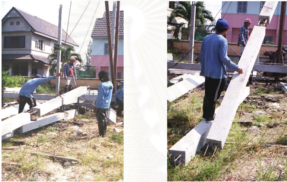
รูปที่ .5-73 แสดงการยกชิ้นส่วนเสาสำเร็จที่ผิดวิธี
