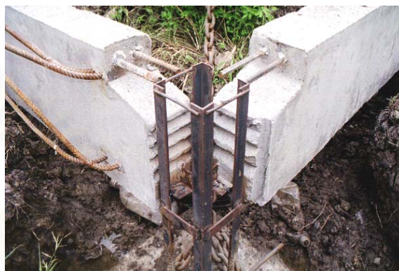
รูปที่ 5-37 แสดงการยกขึ้นส่วนคานคอดินติดตั้ง และตำแหน่งรอยต่อของคานคอดินกับเสา
