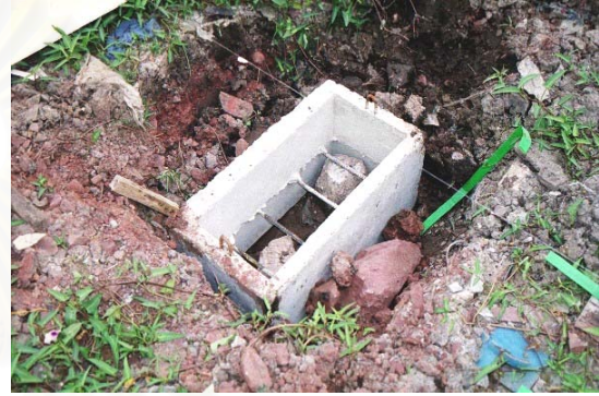
ข. วางตอม่อสวมทับเสาเข็มลงไปที่ยุ่ลุมที่ขุดไว้
