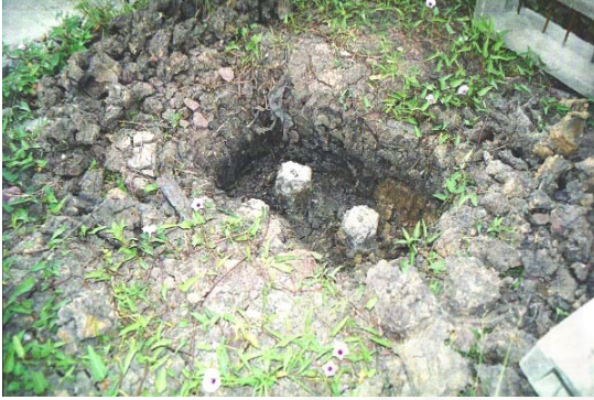
ก. ตอกเสาเข็มสั้นความยาวประมาณ 2.00-2.50 เมตร ลงบริเวณที่ขุดเตรียมไว้
