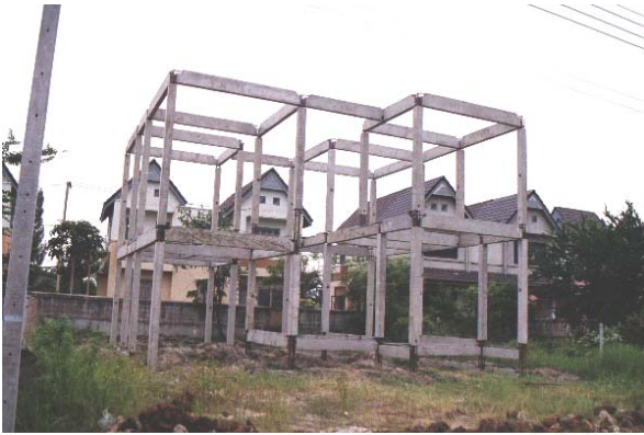
จ. แสดงการติดตั้งชิ้นส่วนเสร็จสิ้น แต่ยังไม่ได้เทพูน ปิดรอยต่อ (ตั้งแต่วันแรกที่ปักผังจนถึงขั้นตอนนี้ใช้ เวลา 11 วัน )
