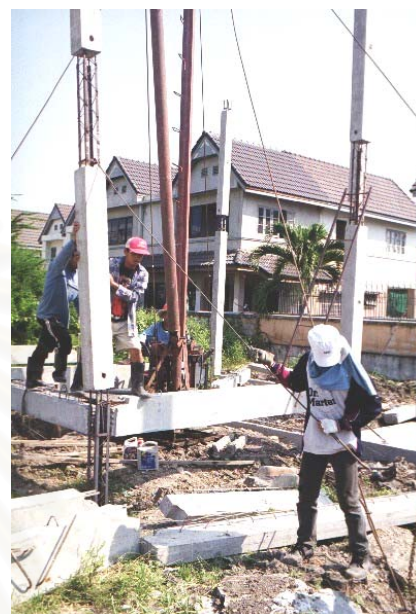
รูปที่ 5-42 แสดงการตัดเหล็กที่ปลายเสา กับการใช้คนงานดึงปรับระดับเสาซ้าย-ขวา
