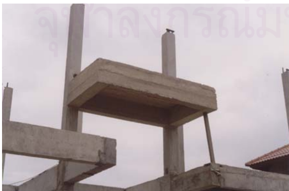
ค. โครงสร้างคานยื่นหล่อในที่ส่วนหลังคาโรงบันได
