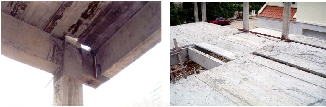
รูปที่ .5-80 . แสดงการปูพื้นสำเร็จรูปที่มีขนาดไม่พอดีกับช่วงเสา
