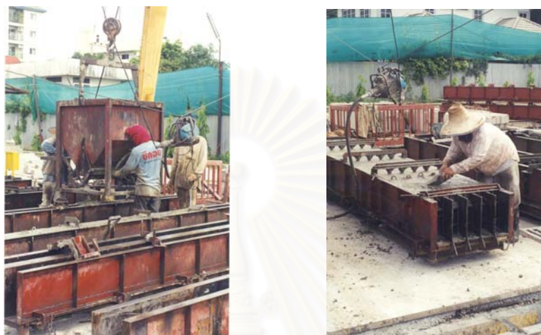
รูปที่ 5-11 . การเทคอนกรีตและการแต่งผิว
