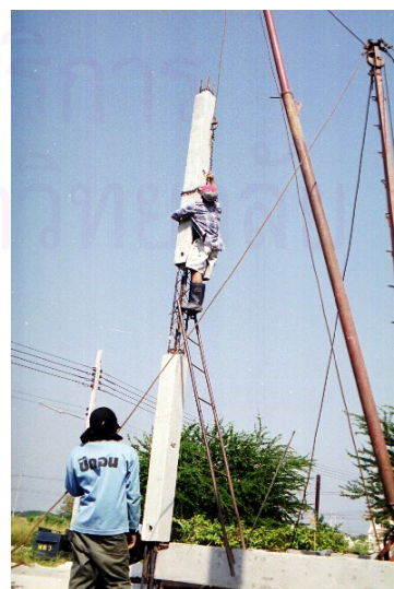
รูปที่ 5-43 แสดงการปรับระดับ, วัดตั้งเสา และการถอดโซ่รัดเสาวัวออกเมื่อทำการติดตั้ง
