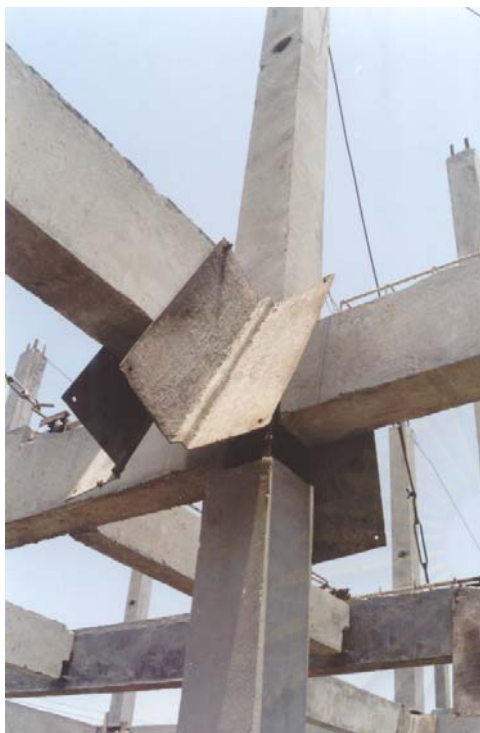
ก. ไม้แบบเหล็กที่เสากลางอาคาร
