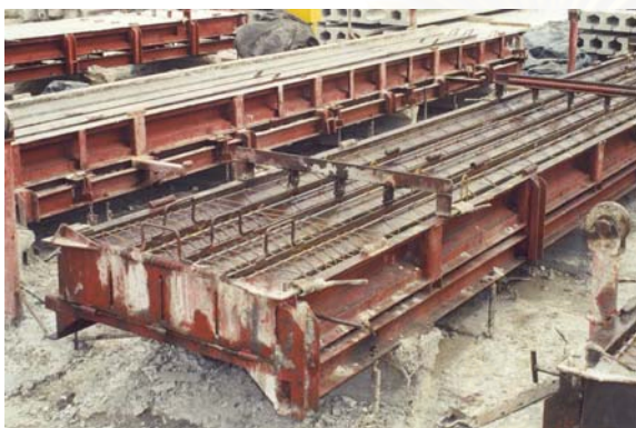
รูปที่ 5-9 แสดงการใส่โครงเหล็กในแบบหล่อ
