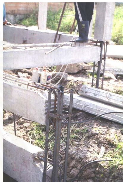
รูปที่ 5-40 แสดงการตัดเหล็กโครงเสาออกเพื่อทำการปรับระดับ
