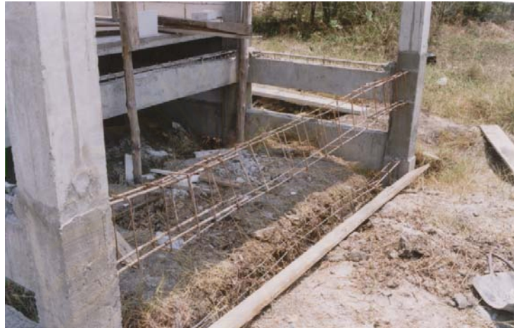
รูปที่ 5-57 แสดงการเสริมเหล็กเพื่อหล่อคานในที่ (คานคอดิน และคานระเบียงชั้น 1)
