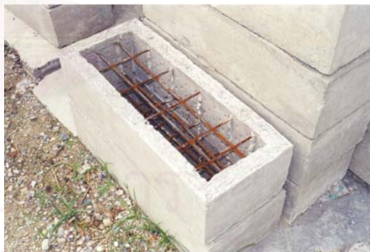
รูปที่ .5-21 . แสดงชิ้นส่วน เสาเข็ม และตอม่อสำเร็จรูป
