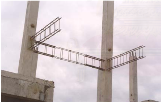
ก. การเสริมเหล็กเพิ่มจากเหล็กเดิมที่ไหลจากชิ้นส่วนเสา
