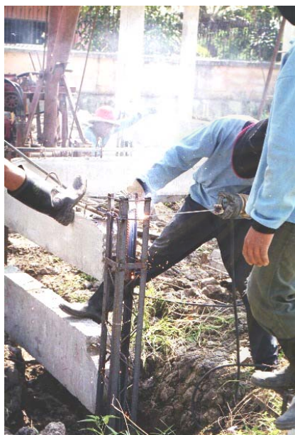
รูปที่ 5-40 แสดงการตัดเหล็กโครงเสาออกเพื่อทำการปรับระดับ
