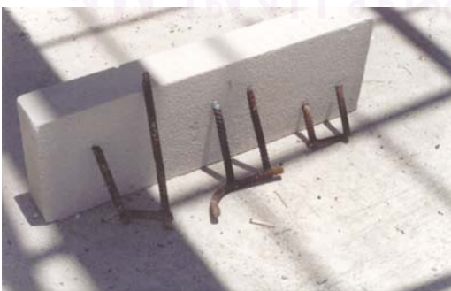
รูปที่ 5-70 .แสดงการติดตั้งโครงหลังคาเหล็กด้วยเหล็กเสริม
