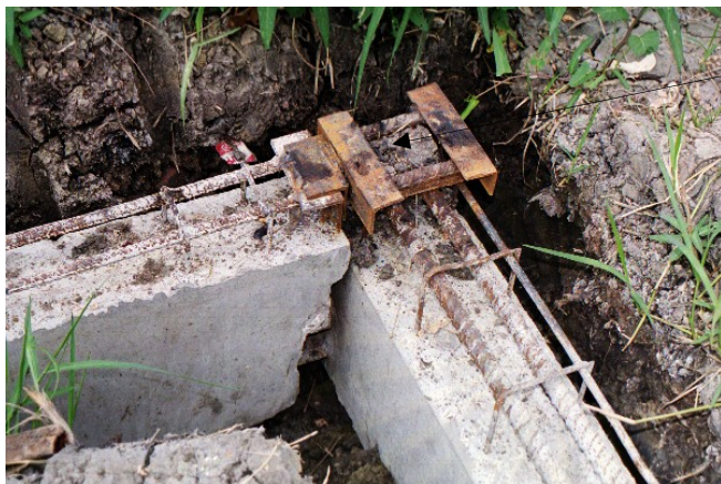
รูปที่ 5-48 . แสดงการคานคอดินชนิดไม่มีเสา
