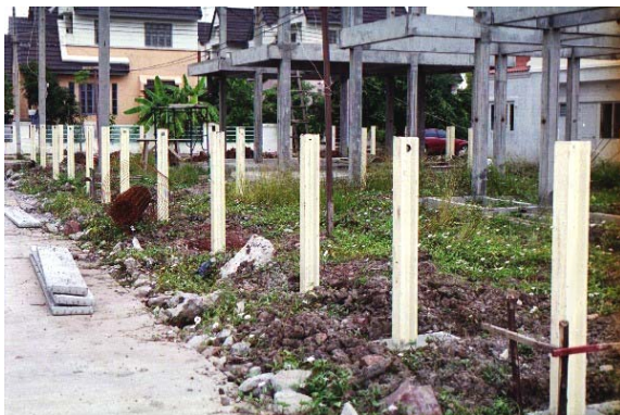
จ. ทำการติดตั้งเสาทุกต้นจนเสร็จ
