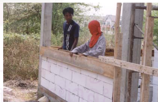
ข. การตีไม้แบบหล่อคานทับหลัง
