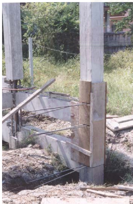
ก. ไม้แบบ - ไม้ บริเวณที่มีคานหล่อในที่
