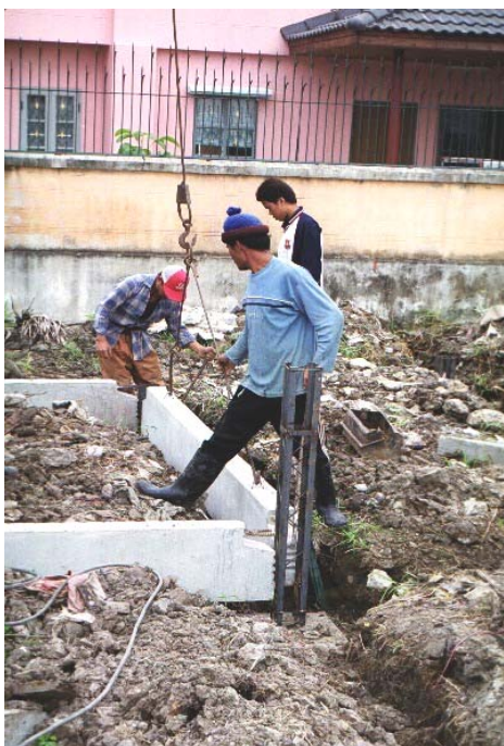
รูปที่ 5-37 แสดงการยกขึ้นส่วนคานคอดินติดตั้ง และตำแหน่งรอยต่อของคานคอดินกับเสา
