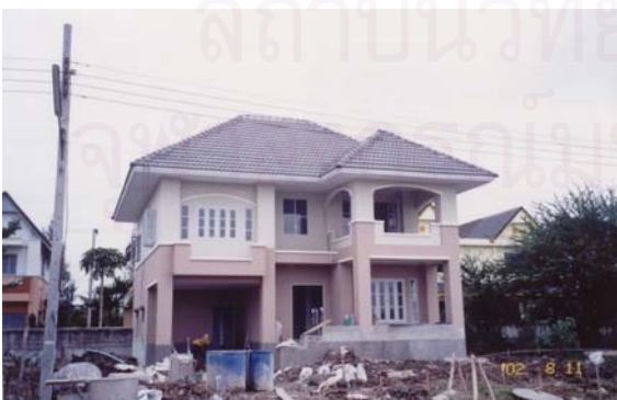
ฏ. แสดงบ้านที่ก่อสร้างเสร็จด้วยระบบ เสา-คานสำเร็จรูป ( ใช้เวลาก่อสร้างในช่วงเวลาจริง 122 วัน )
