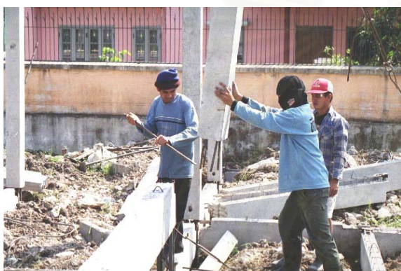
รูปที่ 5-42 แสดงการตัดเหล็กที่ปลายเสา กับการใช้คนงานดึงปรับระดับเสาซ้าย-ขวา
