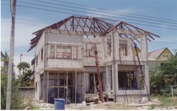
ณ. แสดงวางโครงหลังคาเหล็ก ( 9 วัน )
