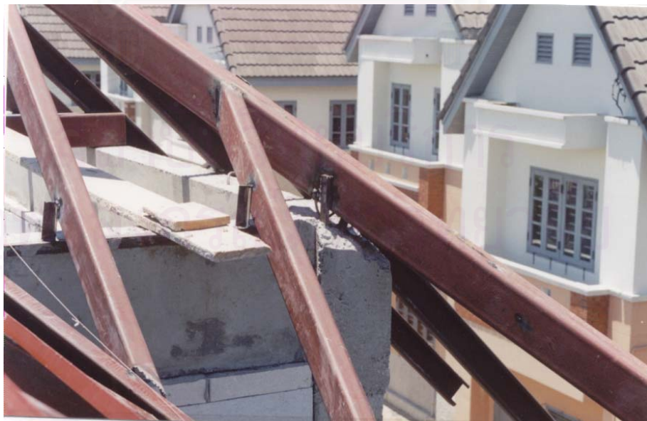
รูปที่ 5-84 แสดงการติดตั้งโครงหลังคาเหล็กด้วยการเชื่อมยึดกับเศษเหล็กเส้นที่เสียบเพิ่มเข้าไปในส่วนเสาคานสำเร็จรูป
