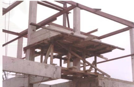
ข. การตีไม้แบบเพื่อหล่อแบบ
