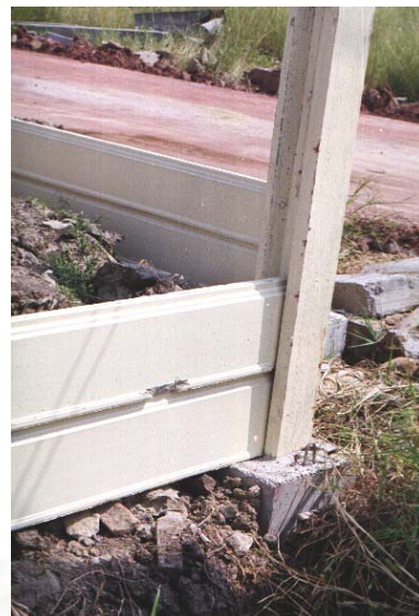
ฉ. นำเอาชิ้นส่วนผนังมาเสียบตรงร่องระหว่างเสา 2 ต้น
