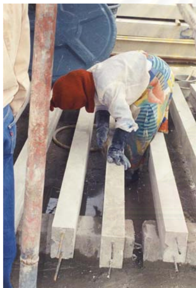
รูปที่ 5-13 แสดงการทำปลาสเตอร์ผิว และการยกชิ้นส่วนที่หล่อเสร็จแล้วไปเก็บด้วย Portal cranes
