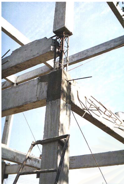
ก. การแยกหล่อแบบสองครั้ง
