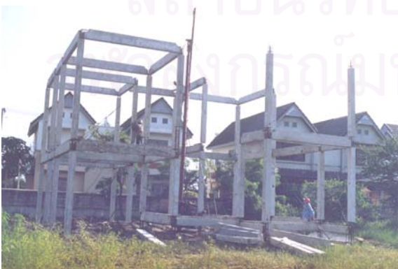
รูปที่ 5-88 แสดงลำดับขั้นตอนและระยะเวลาการก่อสร้าง : ชิ้นส่วนสำเร็จรูปเสา-คาน
