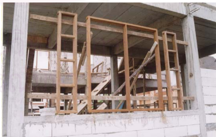
ข. การติดตั้งวงกบหน้าต่างบานใหญ่
