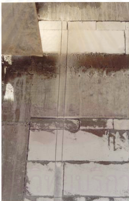
รูปที่ 5-85 แสดงความผิดพลาดในการไม่เผื่องานระบบในขึ้นส่วนสำเร็จรูป
