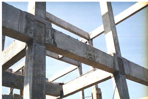
ข. เมื่อถอดแบบออก โครงสร้างอาจดูไม่เรียบร้อย ต้องมีการฉาบแต่งผิว
