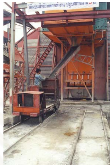
รูปที่ 5-10 . แสดงการเทคอนกรีตผสมลงใน Bucket เพื่อนำไปเทแบบ
