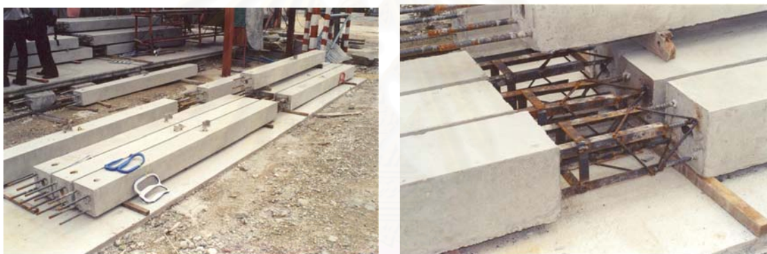
รูปที่ 5-18 แสดงชิ้นส่วน เสาสำเร็จรูปแบบต่อเนื่อง
