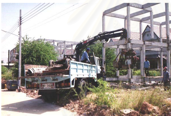
รูปที่ 5-49 . แสดงการเก็บ Guy derrick Cranes ด้วยรถเครนขนาดเล็ก
