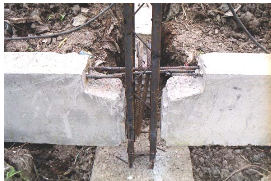
ข. การใช้คาน 3 คานต่อเสา 1 ต้น โดยใช้เหล็กเสริมแบบงอเป็นฉาก 2 เส้น และแบบตรง 2 เส้น
