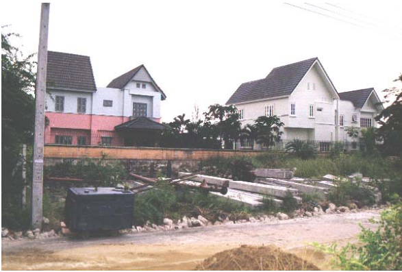
ก. แสดงการเตรียมผังงานก่อสร้าง (3 วัน)
