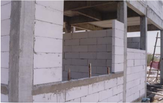
รูปที่ 5-65 แสดงการติดตั้งไม้ปรับระดับวงกบ
