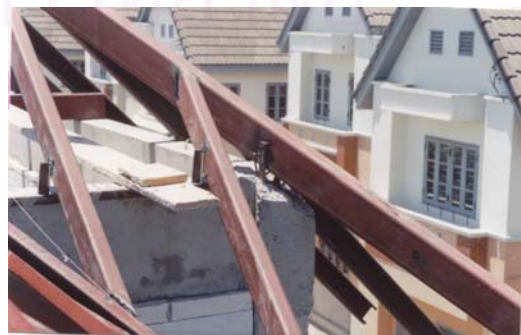
รูปที่ 5-70 .แสดงการติดตั้งโครงหลังคาเหล็กด้วยเหล็กเสริม
