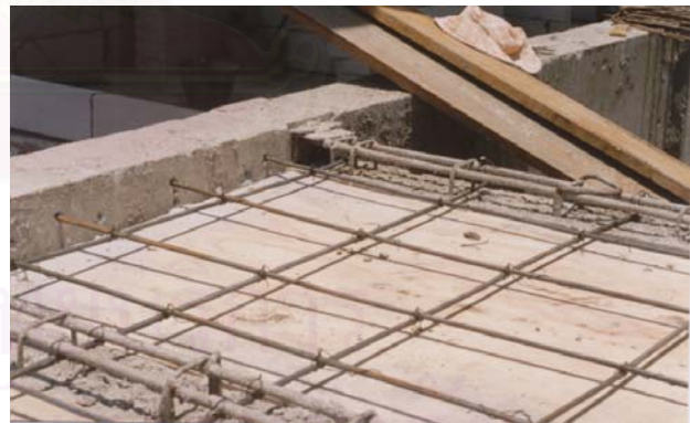
ข. การฝังปลายเหล็กเส้นของเหล็กตะแกรงกับชั้นส่วนคานสำเร็จรูป
