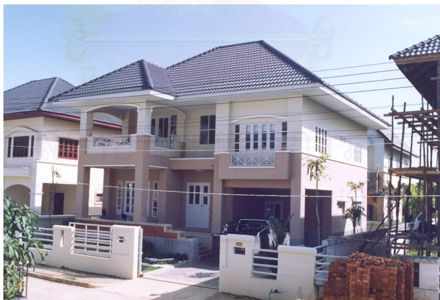
รูปที่ 4-4 แสดงบ้านแบบคุณภาพลักษณะ ซึ่งเป็นบ้านในกรณีศึกษา ที่ก่อสร้างด้วยระบบเก๋าก่อสร้างแบบทั่วไป
