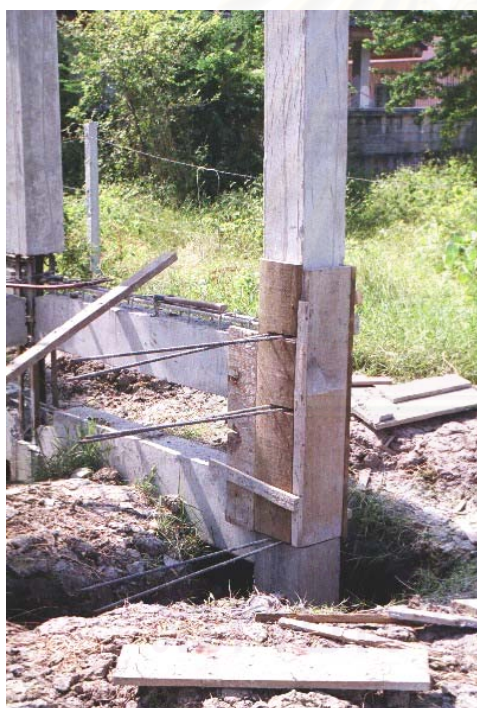
ก. แสดงการใช้ไม้แบบไม้ในส่วนที่ไม่สามารถ ใช้ไม้แบบเหล็ก
