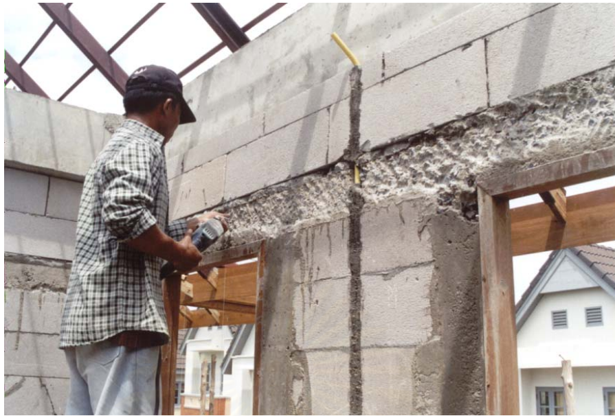
รูปที่ 5-83 แสดงการสกัดคานทับหลังที่หล่อเพิ่ม เกินความหนาของวงกบหน้าต่าง
