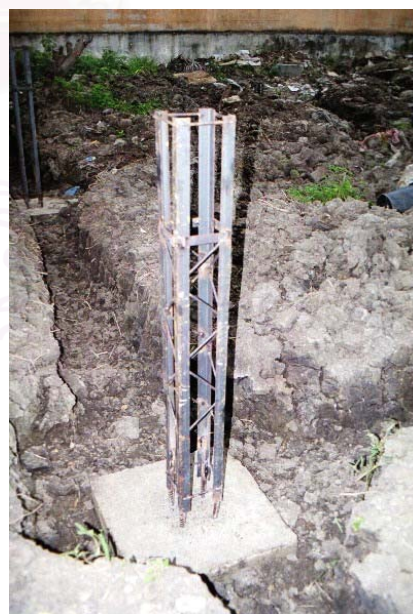
รูปที่ 5-36 แสดงการต่อเสาเหล็กสำเร็จรูปเสริมปรับระดับ
