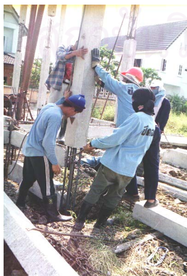
รูปที่ 5-43 แสดงการปรับระดับ, วัดตั้งเสา และการถอดโซ่รัดเสาวัวออกเมื่อทำการติดตั้ง
