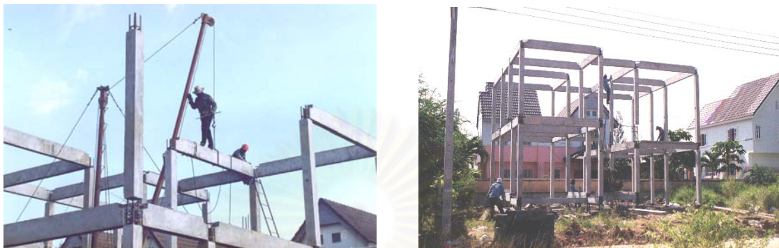
รูปที่ 5-44 แสดงการติดตั้งคานชั้น 2 และการติดตั้งคานส่วนหลังคา
