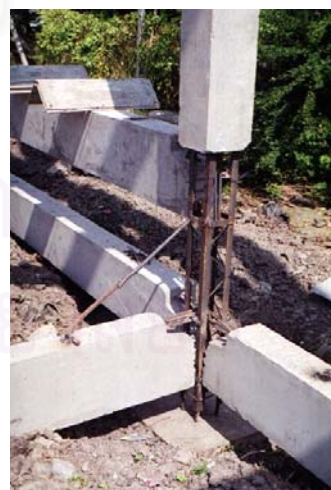
ฉ. การใช้ตะขอเหล็กปรับระดับได้ ยึดขึ้นส่วนเสา-คาน เพื่อให้เหล็กที่เพิ่งเชื่อมเสร็จจคงตัว แล้วจึงค่อยนำออก
