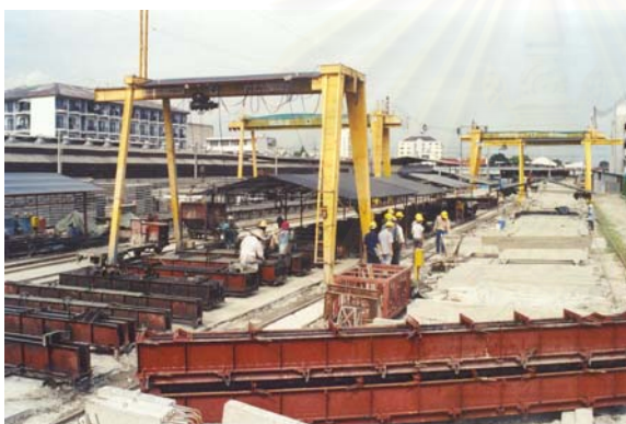
รูปที่ 5-7 . แสดงโรงงานในส่วนของงานหล่อแบบ ชิ้นส่วนคอคตกรีต
