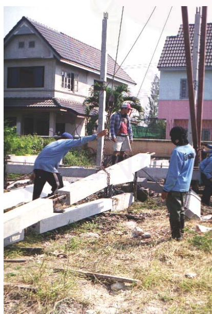
รูปที่ 5-41 แสดงการยกเสาโดยใช้ Guy Derrick cranes ผู้ใกล้ชิดกับส่วนลำตัวเสา แล้ว
