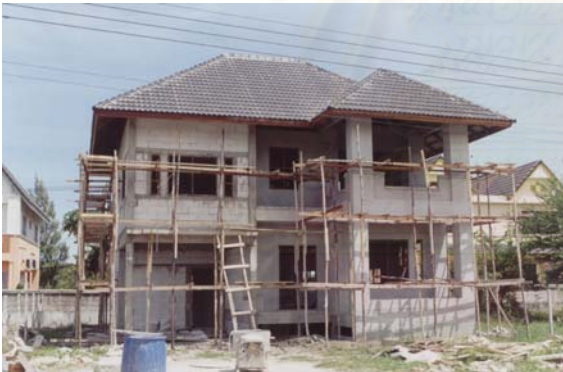
ฎ. แสดงการติดตั้งกระเบื้องหลังคา ( 5 วัน )
