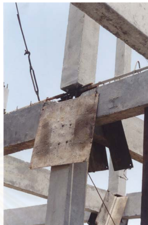
ข. ไม้แบบเหล็กที่เสาด้านริม
