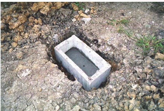
ค. เทคอนกรีตลงให้มิดเสาเข็มพอดี ที่ระยะเวลาให้คอนกรีตเซตตัวระยะหนึ่ง
