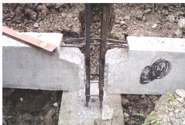
ข. การใช้คาน 2 คานต่อเสา 1 ต้น โดยใช้เหล็กเสริมแบบตรง 1 เส้น
