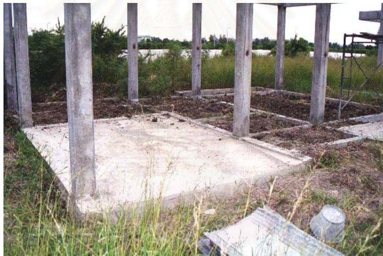
รูปที่ 5-61 แสดงพื้นที่เทคอนกรีตหล่อในที่เสร็จเรียบร้อยแล้ว
