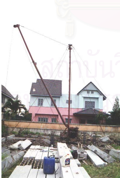
รูปที่ 5-35 . แสดงเครื่อง Guy Derrick cranes
