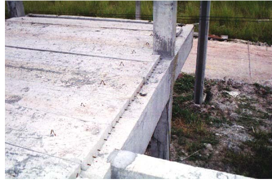
ข. การปูพื้นสำเร็จรูปบนคานที่มีการเจาะร่องของพื้นสำเร็จรูปไว้แล้ว
