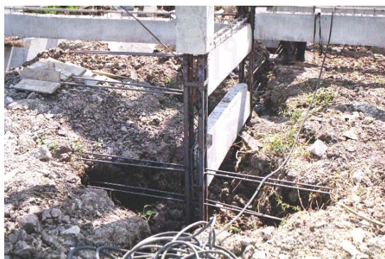
จ. การเสริมเหล็กเส้นยื่นออกจากเสา 4 เส้นบน-ล่าง เพื่อรองรับการหล่อในที่ของคานคอดินตามแบบที่กำหนดไว้
