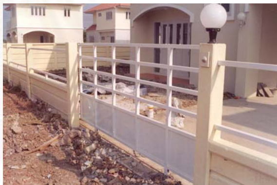
ซ. ทาสี แล้วใส่เหล็กตกแต่งตามแบบ ด้วยวิธีการเชื่อมเหล็กกับเสาสำเร็จรูป
