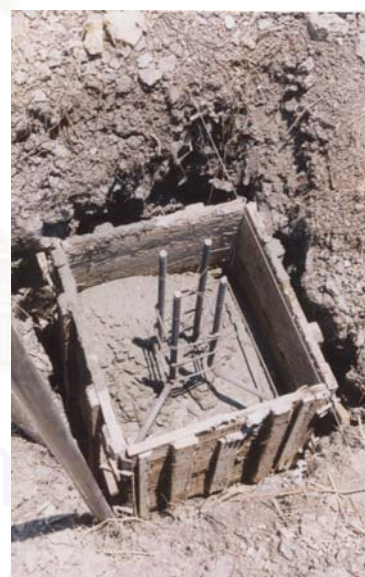
ข. เทคอนกรีตจนเต็ม
