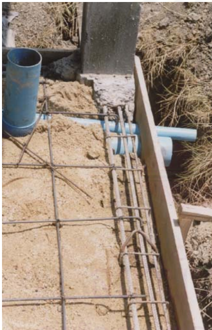
ก. การผูกเหล็กตะแกรงกับเหล็กปลอกบนคานสำเร็จรูป
