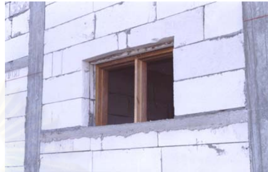
ข. การก่อก่อนนั่งซ้อนแทนการใช้ทับหลังคอนกรีต
