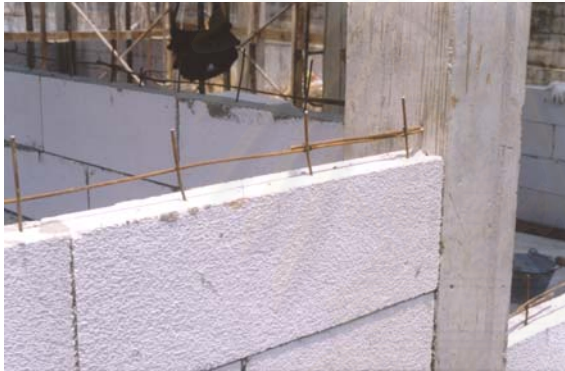
รูปที่ 5-82 แสดงการทำคานทับหลังและการทำวงกบประตู-หน้าต่างที่ไม่ได้มาตรฐาน
