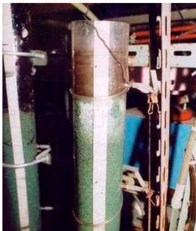
รูปที่ 3.4 การติดตั้งถังปฏิกรณ์ซีโอไลต์รับน้ำออกจากระบบอีจีเอสพี
