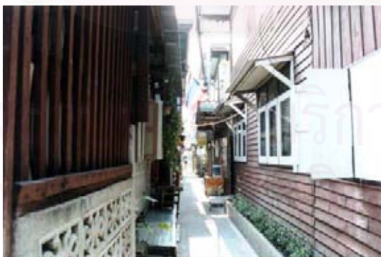
รูปที่4-6 แสดงทางเดินเท้าคอนกรีตยกระดับ ซอยที่ 3
