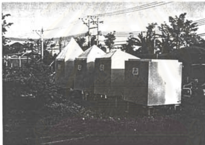
รูปที่ 4 - 8 แสดงการติดตั้งหลังคาของการทดลองชุดที่ 2
