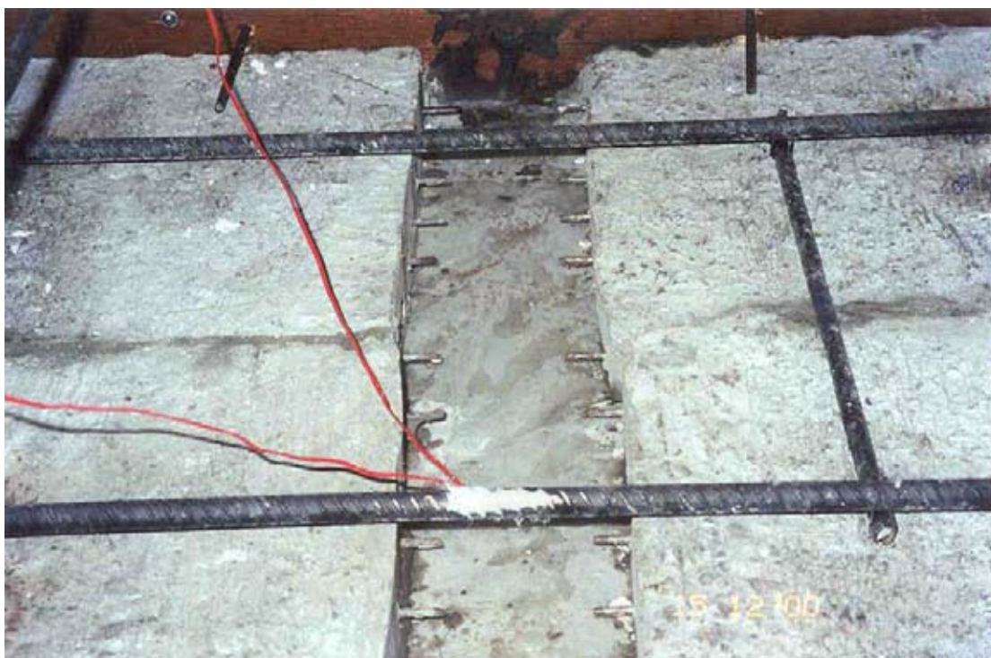
รูปที่ 3.6 การติดตั้งแถววัดความเครียดไฟฟ้าที่เหล็กเสริม
