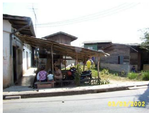
ภาพที่ 3.4 อาคารไม้และครึ่งไม้ครึ่งปูน
