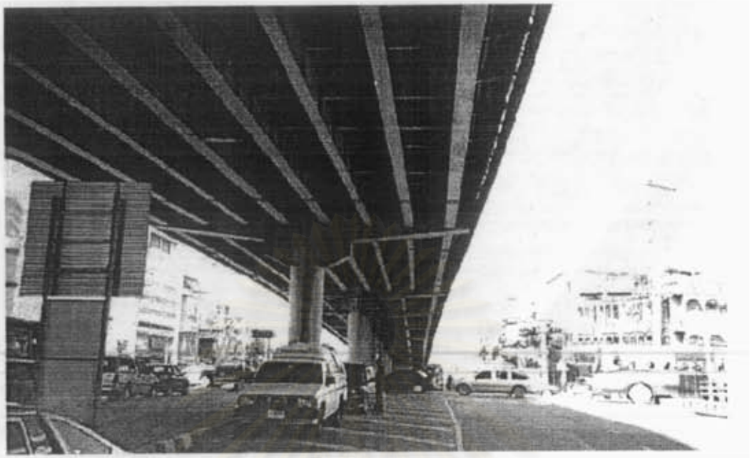
รูปที่ 3-2 ช่วงคานหลักของสะพาน
