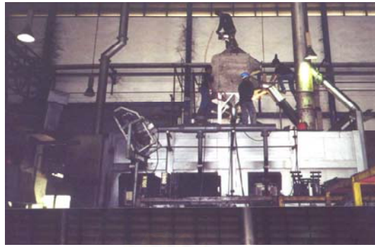
รูปที่ 6.4 รูปแสดงการติดตั้งอุปกรณ์อุ่นอากาศ
