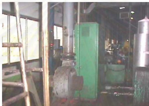
รูปที่ 4.4 Blower ที่เป่าอากาศเข้าสู่เตาเผา
