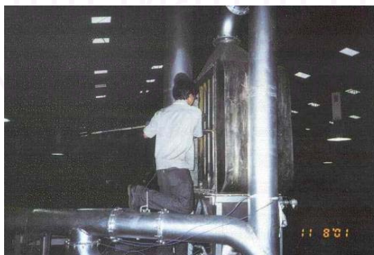
รูปที่ 7.10 การทำความสะอาดอุปกรณ์อุ่นอากาศ
