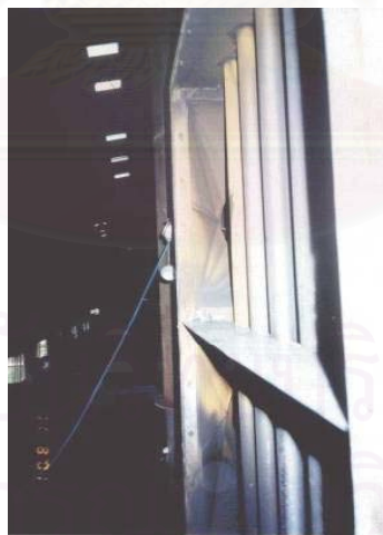
รูปที่ 7.1 ช่องว่างด้านข้างภายในอุปกรณ์อุ่นอากาศ
