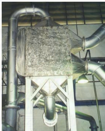
รูปที่ 6.5 อุปกรณ์อุ่นอากาศที่ติดตั้งเรียบร้อยแล้ว
