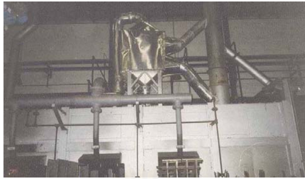
รูปที่ 6.7 อุปกรณ์อุณหอากาศหลังหุ้มฉนวน
