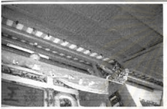
การต่อเติมหลังคาออกจากหลังคาวัดหน้า ที่ศาลเจ้าโรงเกือก
