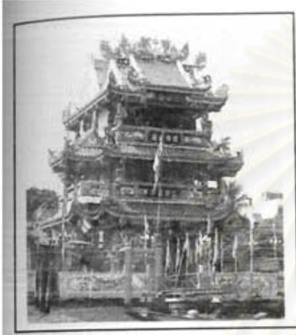
อาคารทรงเจดีย์สูง 3 ชั้น ที่ศาลเจ้าปู่เจ็ยเปี้ย ภาพที่ 218 รูปแบบอาคารใหม่ที่สร้างตามรูปแบบสถาปัตยกรรมจีน
