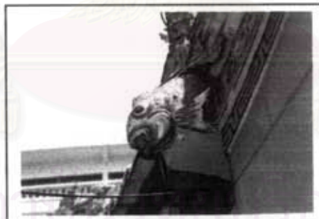
ภาพที่ 227 รางระบายน้ำรูปปลา ที่ศาลเจ้าเซียงกง
