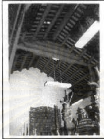
ภาพที่ 226 ปัญหาการเลือกโคมไฟที่มีรูปแบบสมัยใหม่ซึ่งขัดแย้งกับตัวอาคารเก่า (ศาลเจ้าเจิวเอ็ง)
