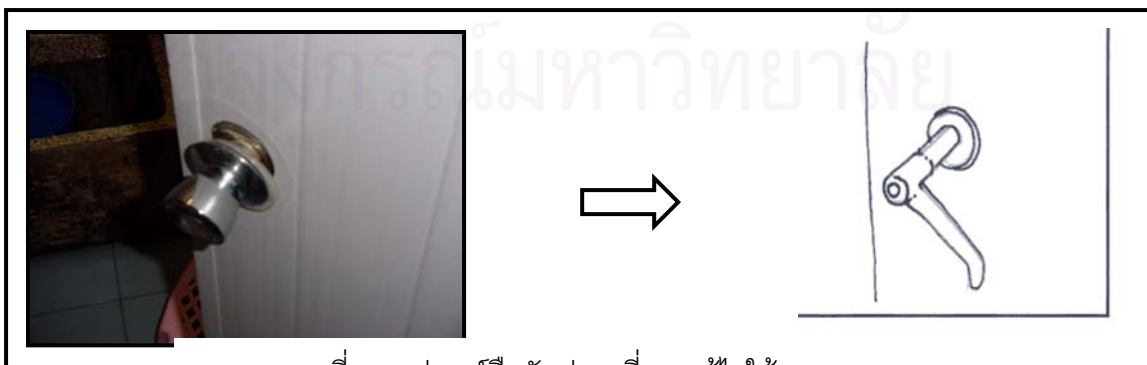
ภาพที่ 87 อุปกรณ์มือจับประตูที่ควรแก้ไขให้เหมาะสม
