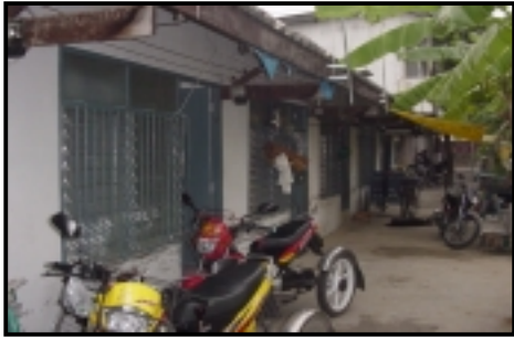
ภาพที่ 9 บ้านแถวอาคารคอนกรีตชั้นเดียว
