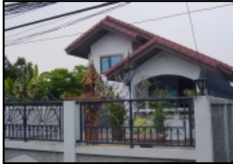
ภาพที่ 17 บ้านเดี่ยวคอนกรีตสองชั้น
