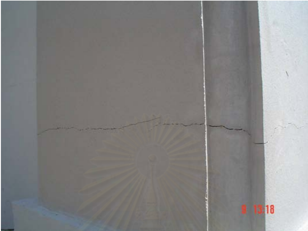
รูปที่ 3.3 ความเสียหายที่เกิดขึ้นในเสาระดับที่ 2
