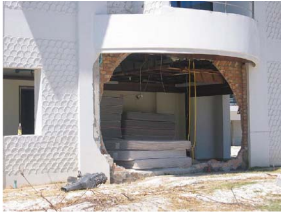
รูปที่ 2.21 การวิบัติด้วยแรงเฉือนของกำแพงอิฐ (Ghobarah, Saatcioglu, และ Nistor, 2005)
