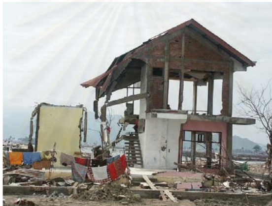
รูปที่ 2.19 โครงสร้างคอนกรีตเสริมเหล็กที่ไม่ได้ออกแบบตามหลักวิศวกรรม (Ghobarah, Saatcioglu, และ Nistor, 2005)
