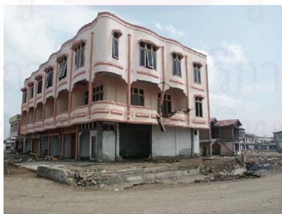
รูปที่ 2.20 โครงสร้างคอนกรีตเสริมเหล็กที่มีการออกแบบตามหลักวิศวกรรม (Ghobarah, Saatcioglu, และ Nistor, 2005)
