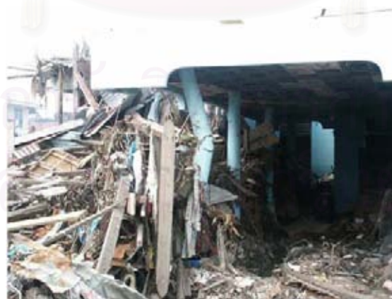
รูปที่ 2.22 ความเสียหายของเสาเนื่องจากแรงกระทำจากคลื่น (Ghobarah, Saatcioglu, และ Nistor, 2005)
