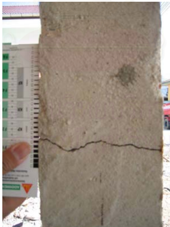
รูปที่ 3.4 ความเสียหายที่เกิดขึ้นในเสาระดับที่ 3
