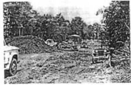
การก่อสร้างถนน รพช.
