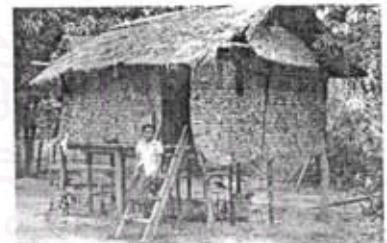
เรือนพักอาศัยกึ่งถาวร
