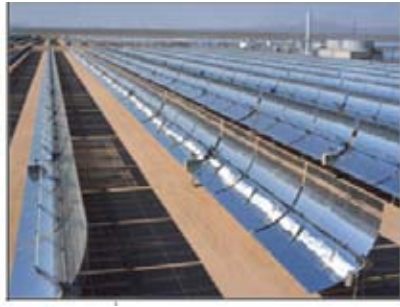
รูปที่3.4 แผงรับพลังงานแสงอาทิตย์แบบรวมแสง
