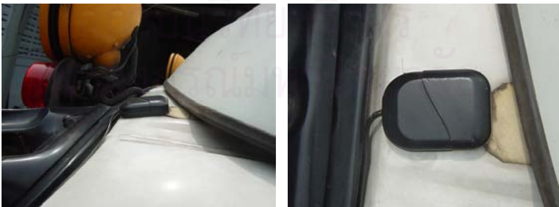
รูปที่ 3.3 การติดตั้งอุปกรณ์รับ - ส่งข้อมูล GPS บนหลังคารถขนส่ง
