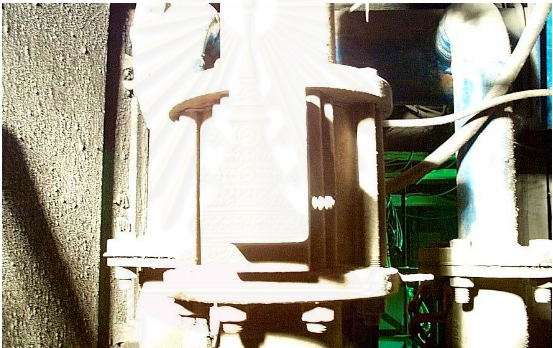
รูปที่ 3.13 แสดงเครื่องวัดอัตราการไหลของน้ำ (Magnetic Flow Meter) ของน้ำหล่อโมลด์ จุฬาลงกรณ์มหาวิทยาลัย
