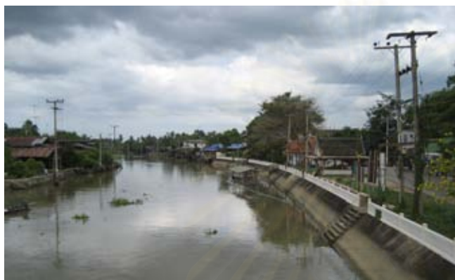
ทัศนียภาพทำเรือที่ปรับปรุงแล้ว ในบริเวณวัดแก้ว เจริญ อ.อัมพวา
