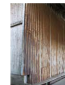
◀ แผงสังกะสีที่ประตูแบบเก่าของเรือนแถวริมน้ำ ปากคลองวัดประดู่
