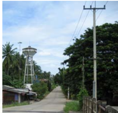
ประปา และไฟฟ้า
