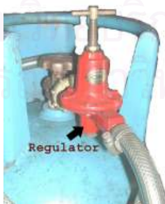
รูปที่ 4-15 แสดงเรกกูเลเตอร์ที่ใช้ในการปรับค่าความดันต้นต้นของก๊าซหุงต้ม
