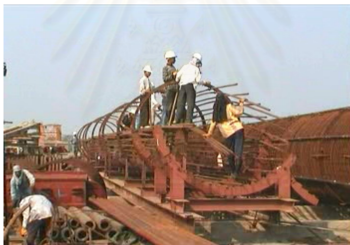
รูปที่ 3.7 แสดงการประกอบโครงเหล็ก
