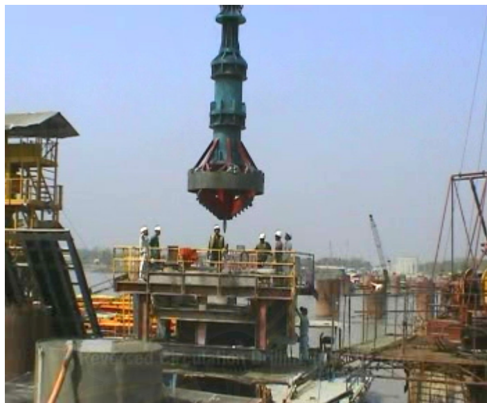
รูปที่ 3.6 แสดงลักษณะของหัวเจาะในการเจาะแบบ Reverse circulation
