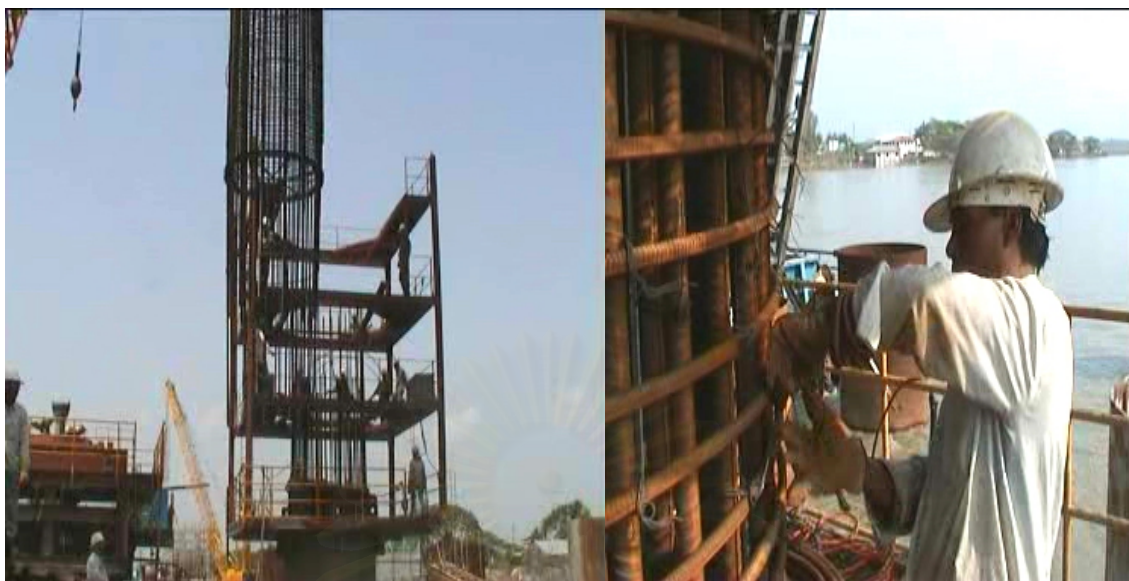
รูปที่ 3.8 แสดงการเชื่อมต่อโครงเหล็ก
