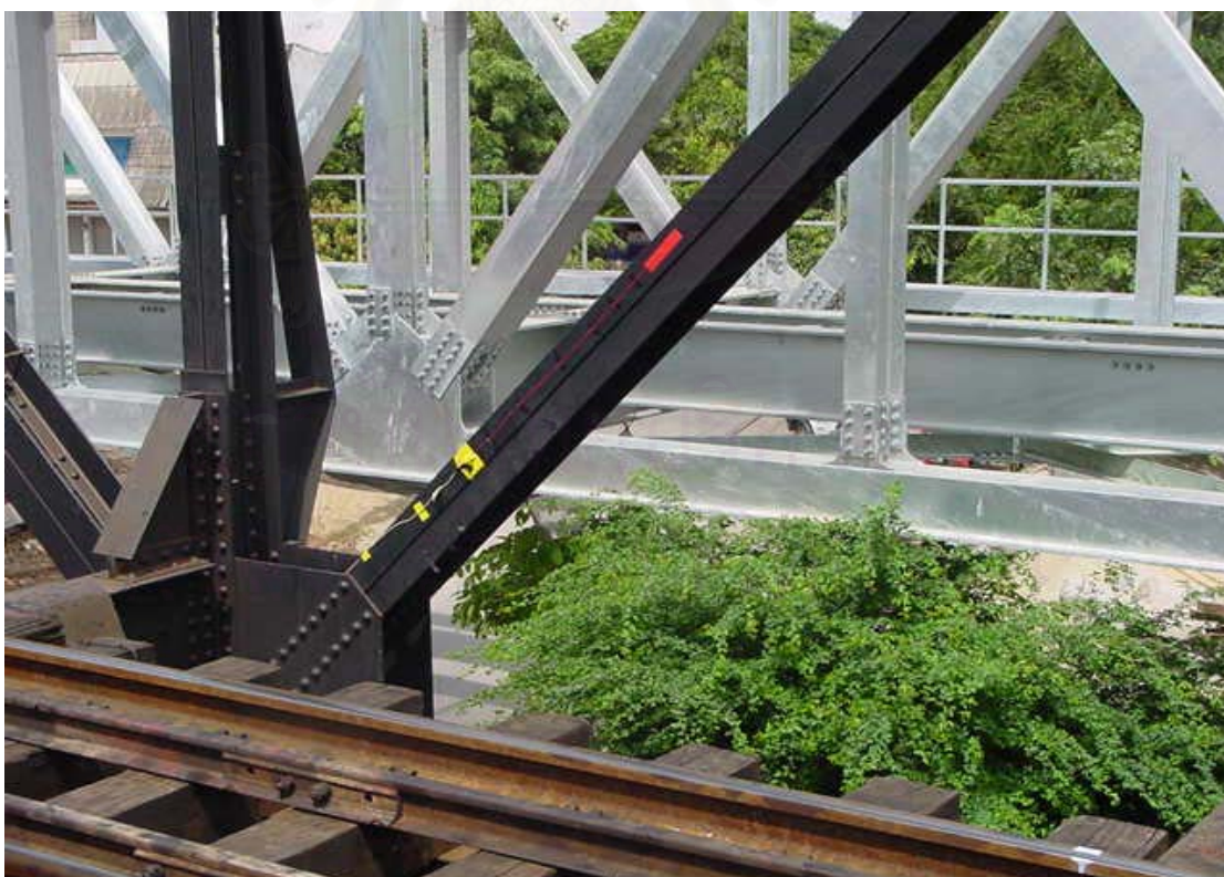
รูปที่ 3-8 สเตรนเกจที่ทำการติดตั้งเรียบร้อยแล้ว
