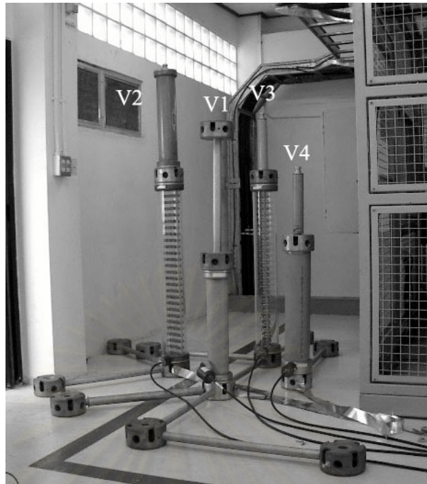
รูปที่ 4.3 การติดตั้งโวลต์จดีไวเดอร์
