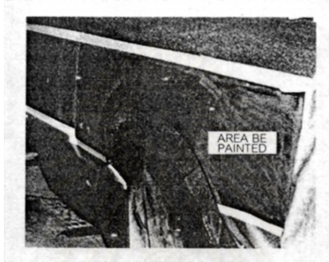
รูปที่ 3 แสดงการติดกระดาษบริเวณขอบกระเบื้องเพื่อป้องกันสีที่พ่นไปติดที่ล้อ
