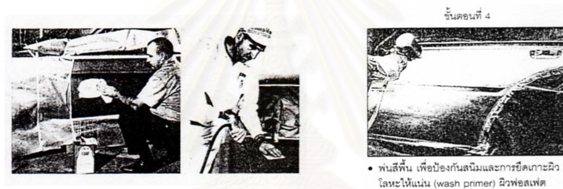
รูปที่ 1 แสดงการทำความสะอาดชิ้นงานและการพ่นพื้นเกาะเหล็ก
