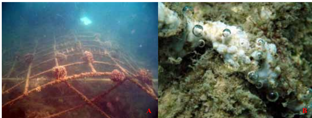
รูปที่ 3.22 โครงสร้างที่ได้รับการกระตุ้นด้วยกระแสไฟฟ้า
