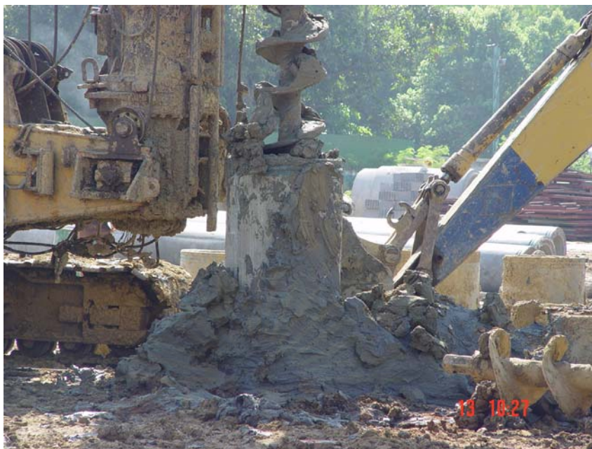
รูปที่ 3.4 ก รูปถ่ายขณะAuger ในชั้นดินเหนียว
