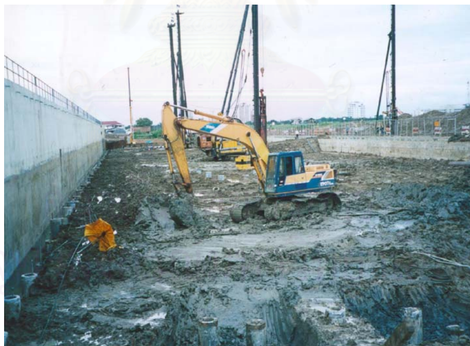
รูปที่ 3.2 ข แสดงลักษณะตำแหน่งเสาเข็มของโครงการก่อสร้างโรงกรองน้ำของการประปา
