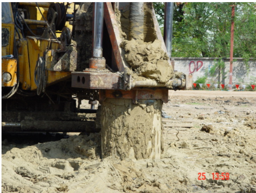
รูปที่ 3.4 ค รูปถ่ายขณะทำการกดหัวเสาเข็ม (Press)
