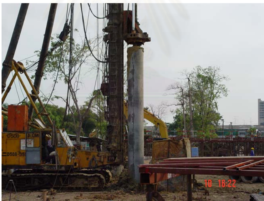
รูปที่ 3.4 ข รูปถ่ายขณะAuger ผ่านชั้นทรายชั้นแรก
