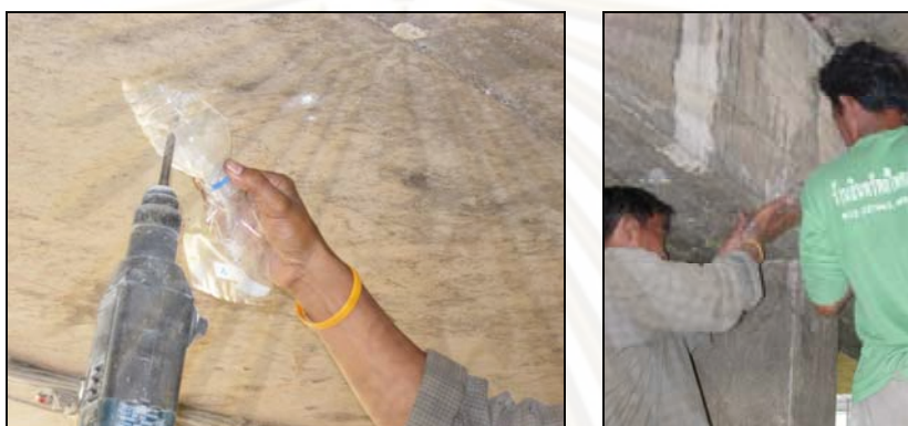
รูปที่ 5.6 การเก็บผงคอนกรีตที่ผิวของโครงสร้าง
