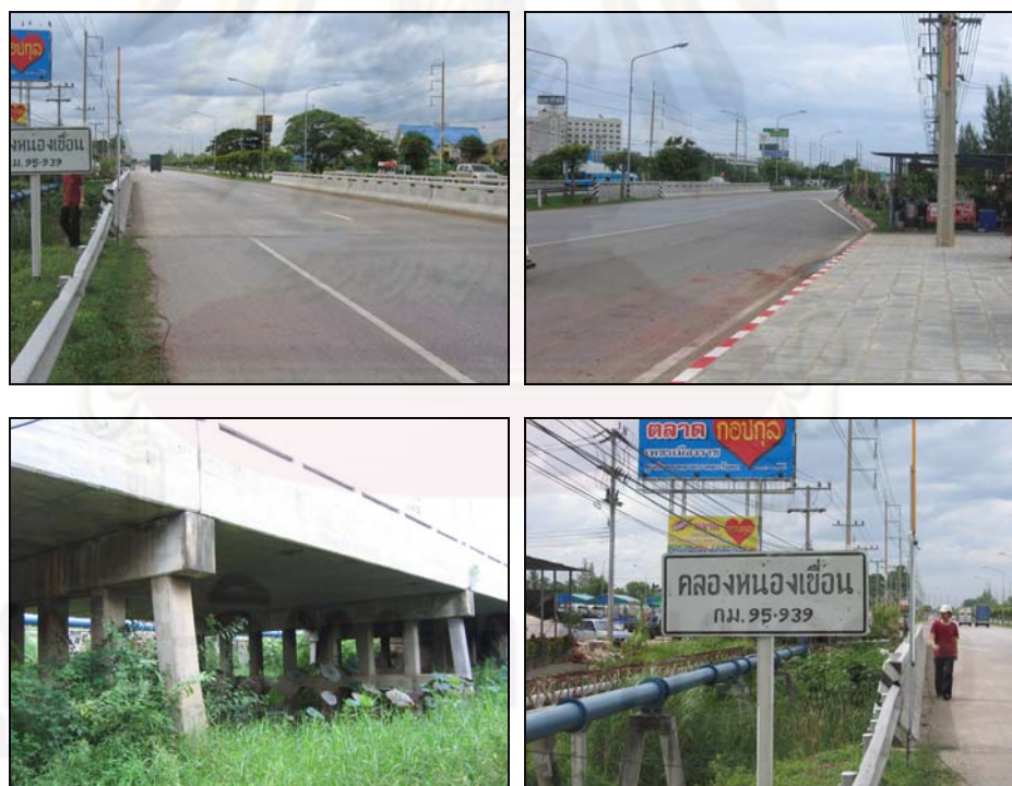
รูปที่ 3.1 สะพานตัวอย่างที่ทำการทดสอบ
