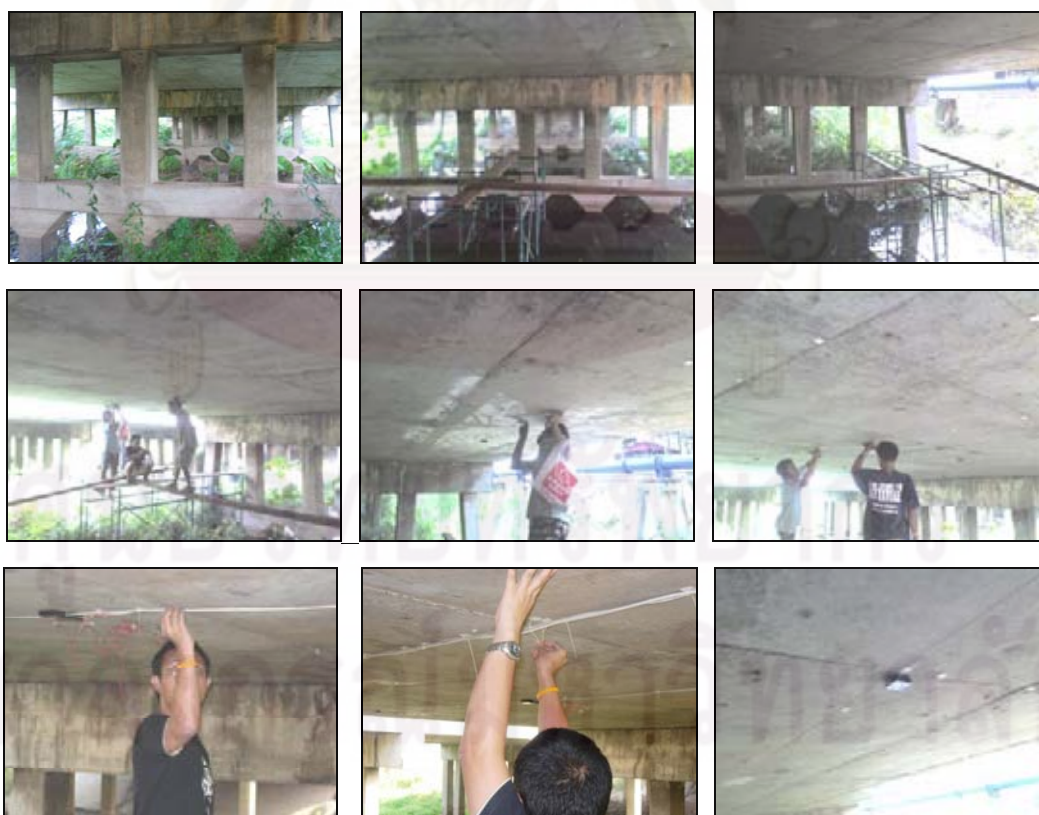
รูปที่ 3.4 ขั้นตอนการติดตั้งอุปกรณ์วัดความเคียดในสะพานเข้ากับแผ่นพื้นคอนกรีต
