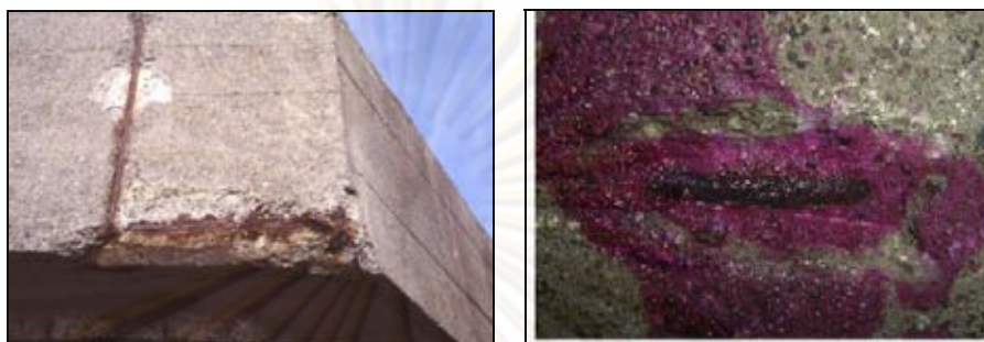
รูปที่ 2.24 คอนกรีตที่เกิดความเสียหายจากการเกิดคาร์บอนขึ้น
