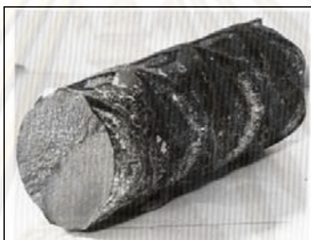
รูปที่ 1.2 การแตกหักของเหล็กเสริมในคอนกรีต
