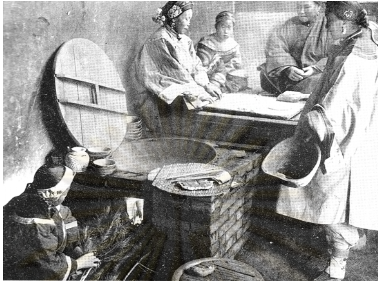
ภาพที่ 4-13 แสดงเตาที่ใช้ในการปรุงอาหารที่มีการเชื่อมต่อกันกับเตียงนอนที่เรียกว่า “ข้าง” (Kang) เพื่อประโยชน์ในการสร้างความร้อนและความชื้นภายในอาคารที่อยู่ในเขตที่มีอุณหภูมิต่ำและมีความชื้นสัมพัทธ์ต่ำ (Knapp, 2005)
