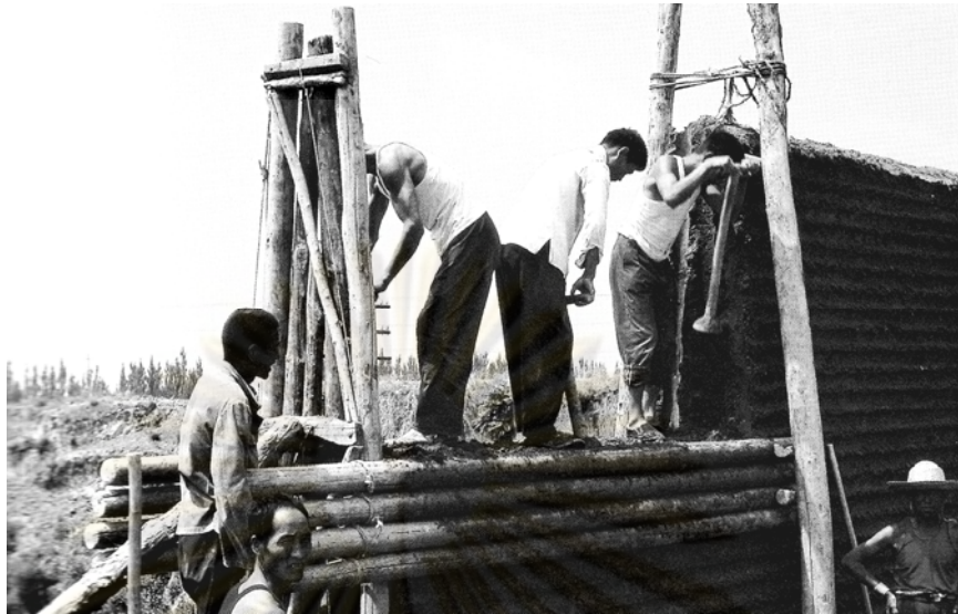
ภาพที่ 2-33 แสดงการก่อสร้างผนังระบบ Tamped Earth หรือผนังที่ใช้การย่ำดิน (Knapp, 2005)
