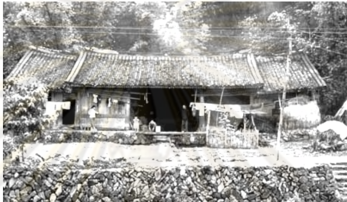
ภาพที่ 4-14 แสดงลักษณะของอาคารพักอาศัยแบบห้าห้องที่หันด้านยาวของอาคารไปทางทิศใต้ ทางตอนใต้ของประเทศจีน ที่ใช้รับแสงอาทิตย์ในฤดูหนาวและใช้รับกระแสลมในฤดูร้อน (Thongkamsamut and Buranakarn, 2007)
