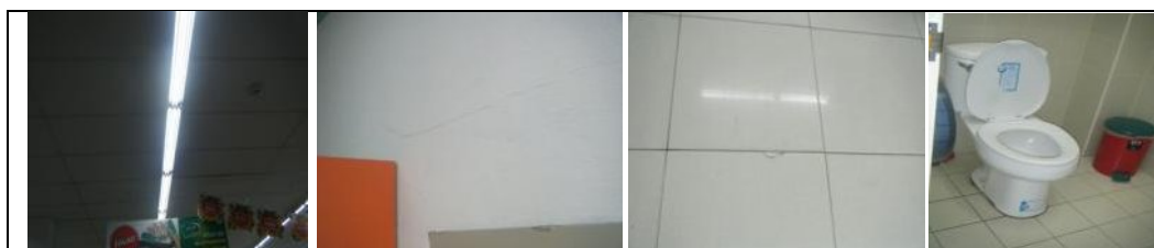
รูปภาพที่ 3.55 สภาพอาคารภายใน
