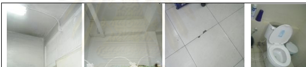
รูปภาพที่ 3.47 สภาพอาคารภายใน
