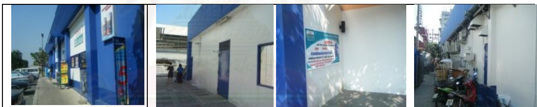
รูปภาพที่ 3.11 สภาพอาคารภายนอก
