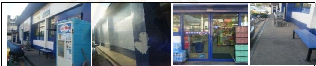
รูปภาพที่ 3.7 สภาพอาคารภายนอก
