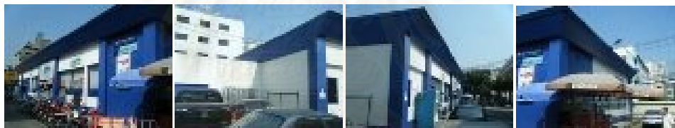
รูปภาพที่ 3.3 สภาพอาคารภายนอก
