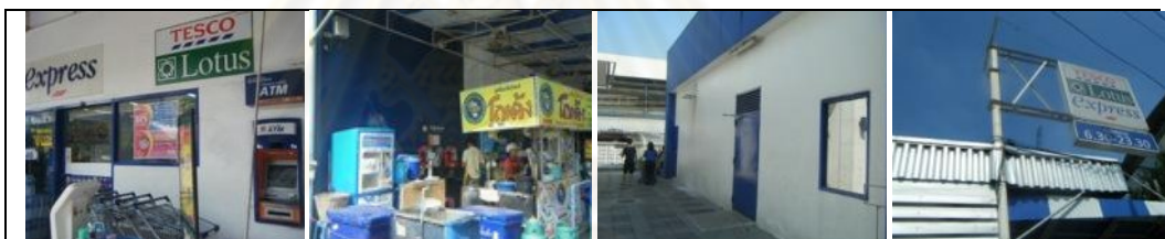
รูปภาพที่ 3.24 สภาพอาคารภายนอก
