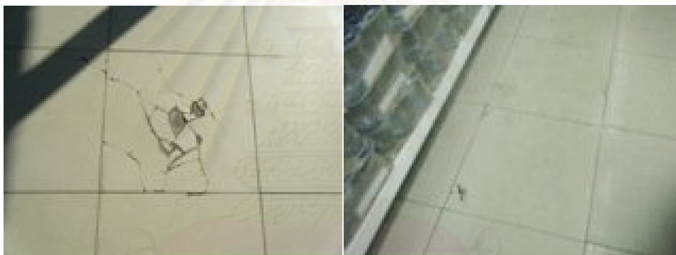
รูปภาพที่ 5.1 สภาพอาคารภายใน
