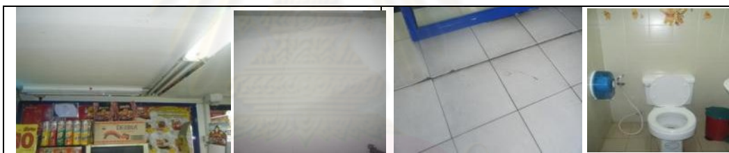
รูปภาพที่ 3.21 สภาพอาคารภายใน
