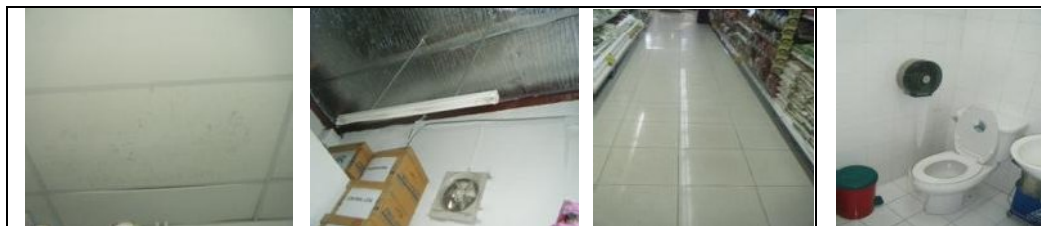
รูปภาพที่ 3.42 สภาพอาคารภายใน
