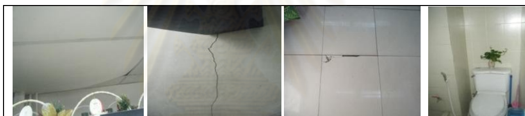
รูปภาพที่ 3.34 สภาพอาคารภายใน
