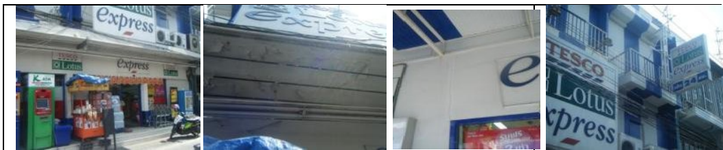
รูปภาพที่ 3.46 สภาพอาคารภายนอก
