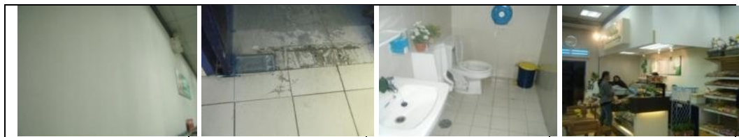
รูปภาพที่ 3.8 สภาพอาคารภายใน
