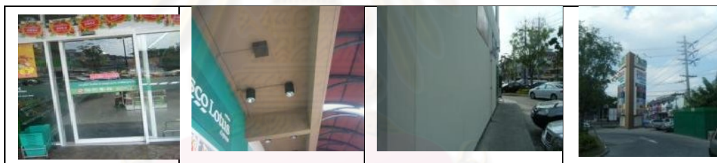
รูปภาพที่ 3.54 สภาพอาคารภายนอก
