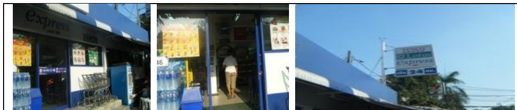
รูปภาพที่ 3.33 สภาพอาคารภายนอก
