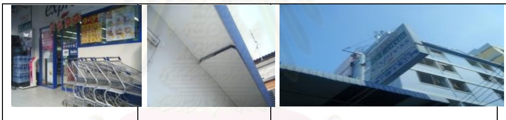
รูปภาพที่ 3.41 สภาพอาคารภายนอก
