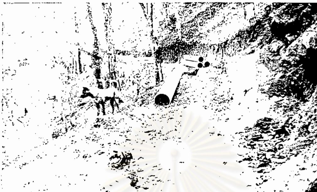
รูปที่ 19 ง. ท่อค้ำน้ำจากฝายไปยังโรงไฟฟ้า ทำโดยใช้แรงงานชาวบ้านขุดฝังเรียบไปตามไหล่เขา
