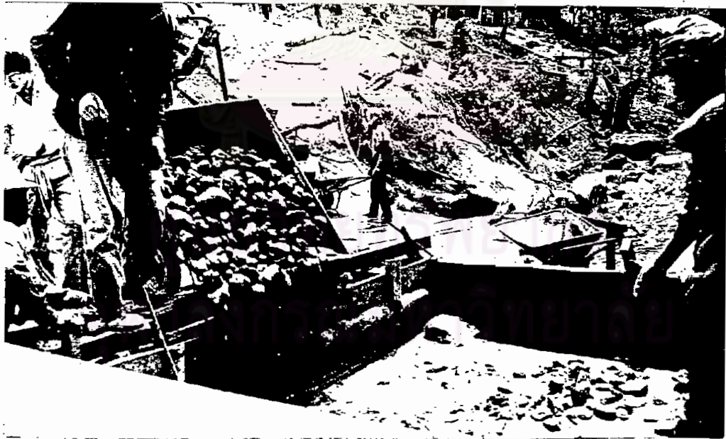
รูปที่ 18 ง. การใช้วัสดุในท้องถิ่น เช่น หิน กรวด ทราย ในงานคอนกรีต ช่วยลดค่าก่อสร้างได้มาก
