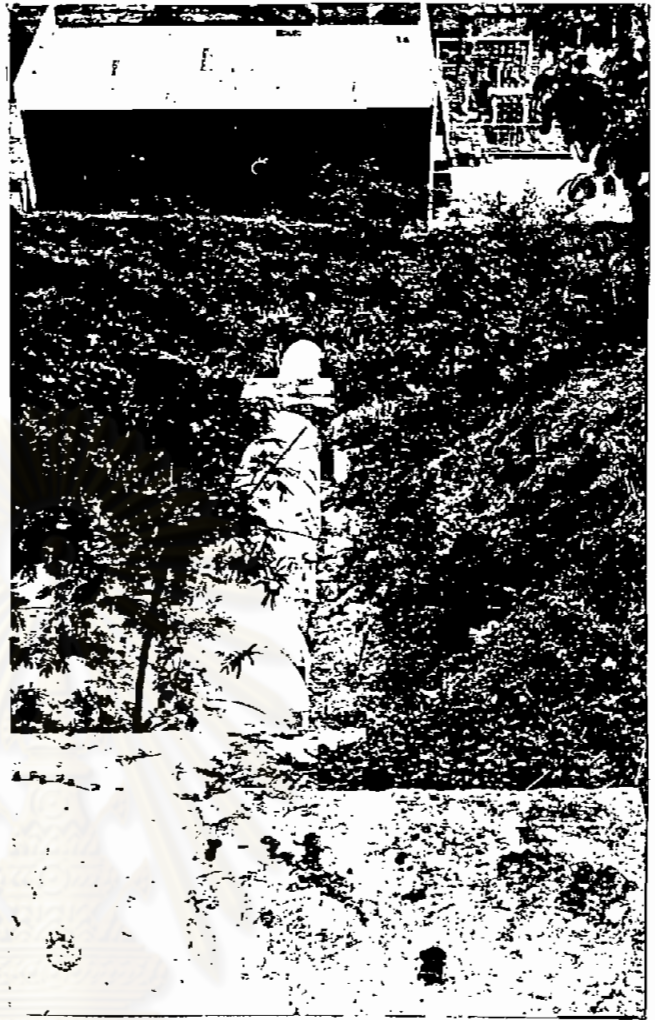
รูปที่ ค..20 ท่อส่งน้ำไปยังโรงไฟฟ้า เพื่อผลิตกระแสไฟฟ้า
