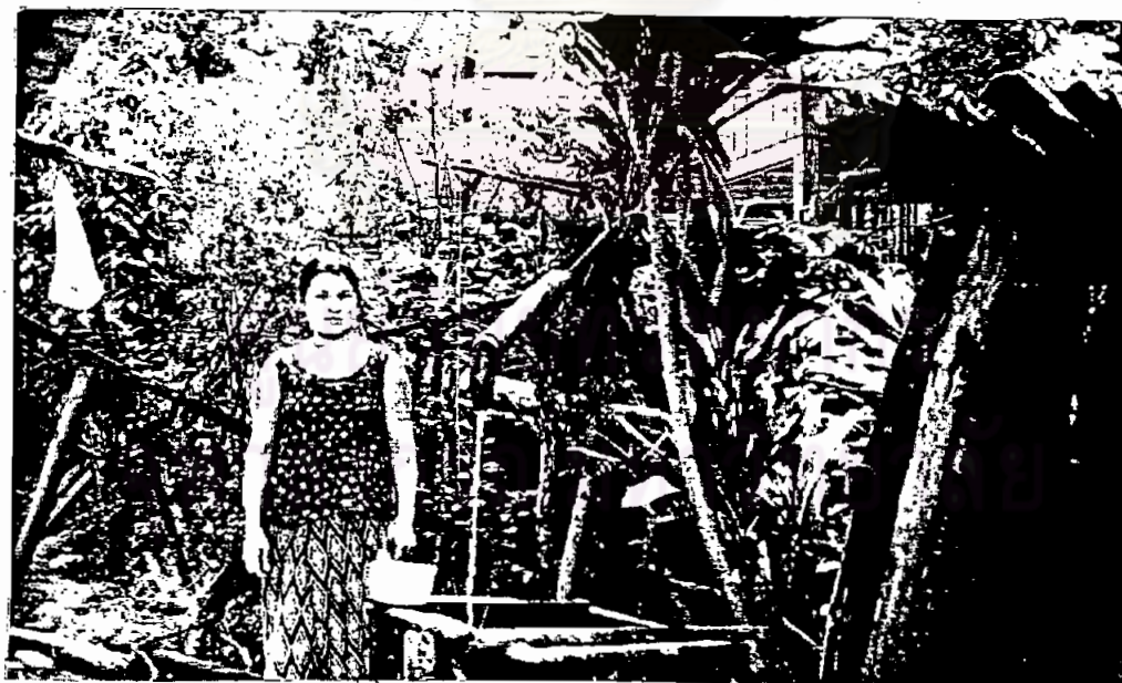
รูปที่ 27 ง. ระบบประปาในชนบทต่อจากลำธารด้วยท่อไม้ไผ่ เป็นตัวอย่างการใช้เทคโนโลยีเหมาะสม
