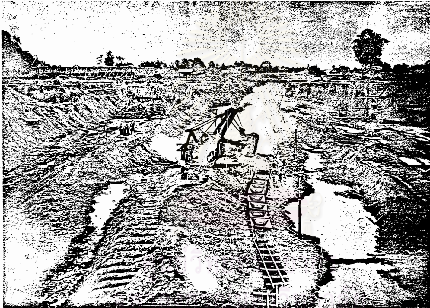
เครื่องจักรขุดดินกำลังทำการขุดรากเขื่อนพระเทพีบรมราชา 1
