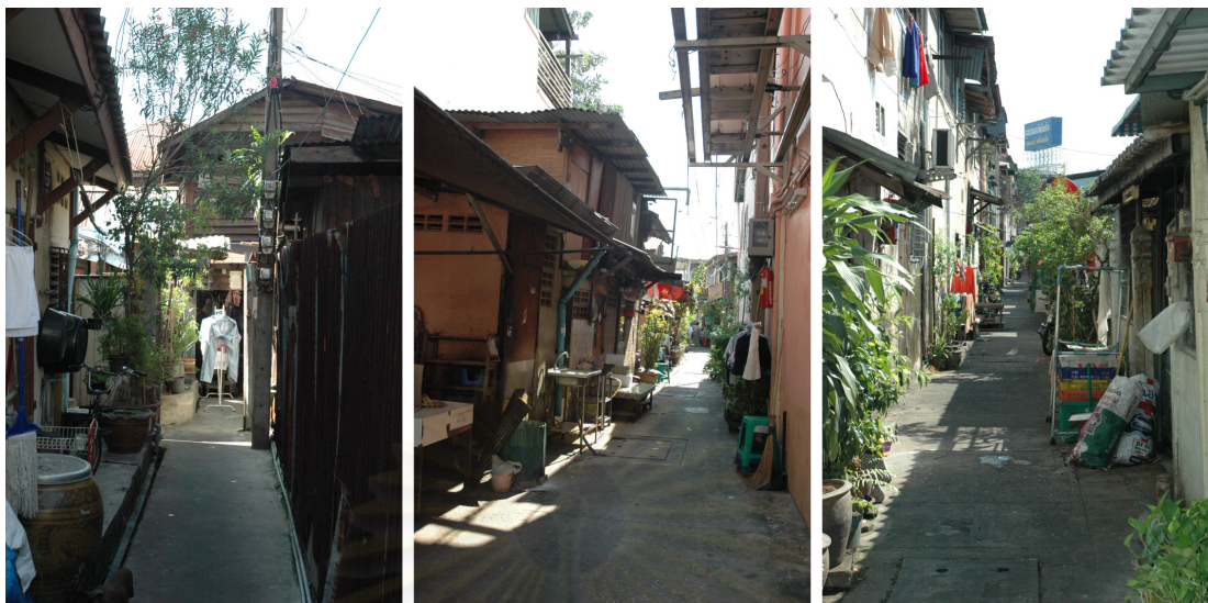
รูปที่ 5.3 แสดงสภาพถนนภายในชุมชนที่มีขนาดเล็กทำให้รถดับเพลิงไม่สามารถเข้าถึงได้
