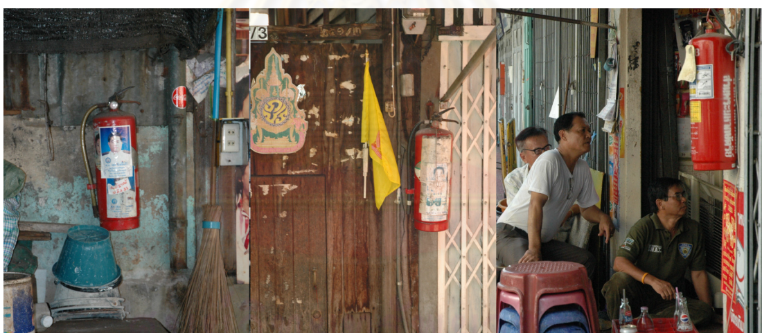
รูปที่ 5.4 แสดงบริเวณที่มีถังดับเพลิงติดไว้ เพื่อรองรับเหตุอัคคีภัย
