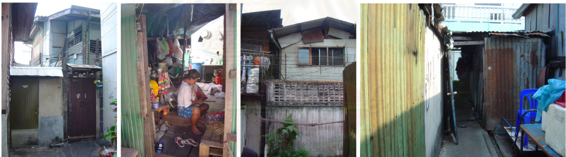
อาคารที่อยู่อาศัยที่มีสภาพทรุดโทรม
