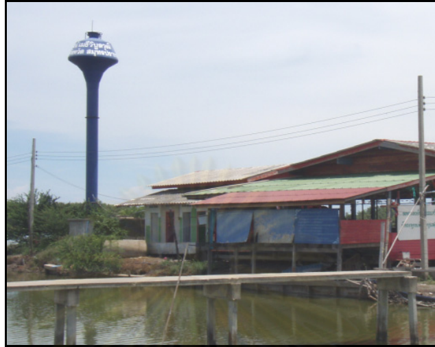
ภาพที่ 4.2 ระบบประปาหมู่บ้าน
