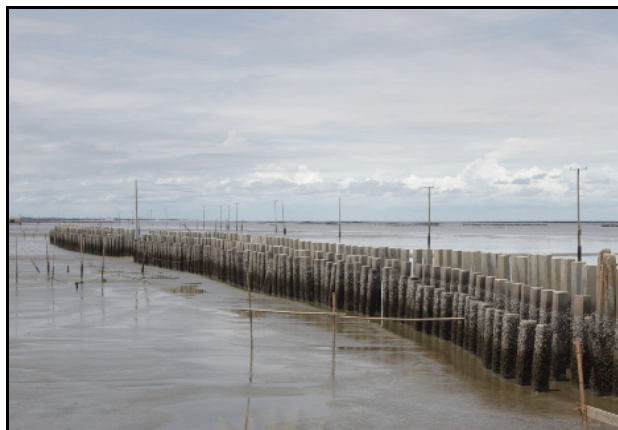
ภาพที่ 6.18 เขื่อนสลายกำลังคลื่นชุมชนสมุทรจีน 49A2
