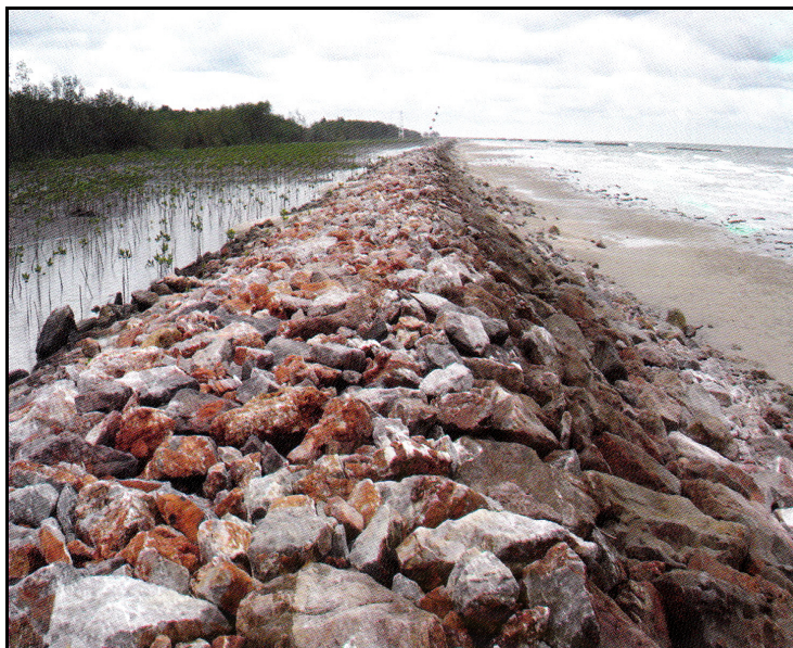
ภาพที่ 2.20 เขื่อนป้องกันคลื่น บริเวณชายฝั่งแหลมหลวงรีสอร์ท อ.บ้านแหลม จ.เพชรบุรี ที่มา: สผ., 2550: 32
