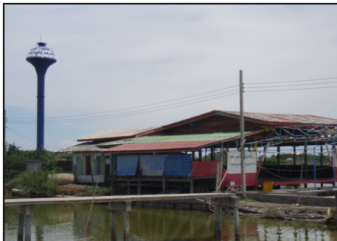
ภาพที่ 6.8 ระบบประปาหมู่บ้าน
