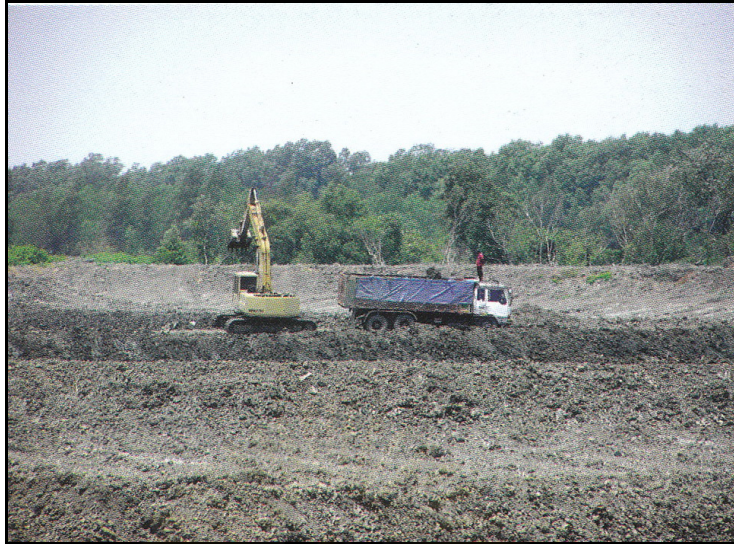
ภาพที่ 2.10 อูร์กิจชุดบ่อเพื่อตักตะกอนดินเลน ต.บางหญ้าแพรก อ.เมือง จ.สมุทรปราการ ที่มา: สผ., 2550: 27
