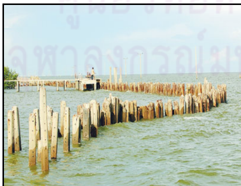
แนวกันคลื่นที่ชาวบ้านทำขึ้นจากเสาไฟฟ้า
