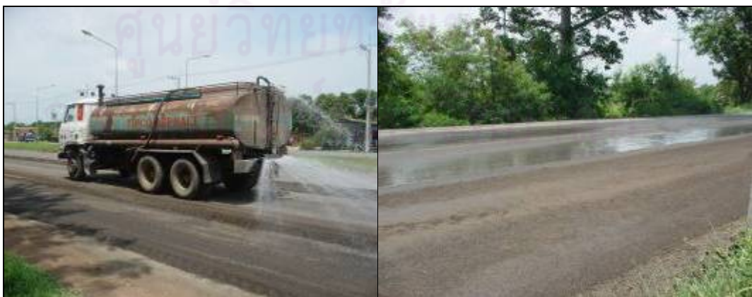
ภาพที่ 4.25 การสเปรย์น้ำเพื่อปมชื้นพื้นทางใหม่
