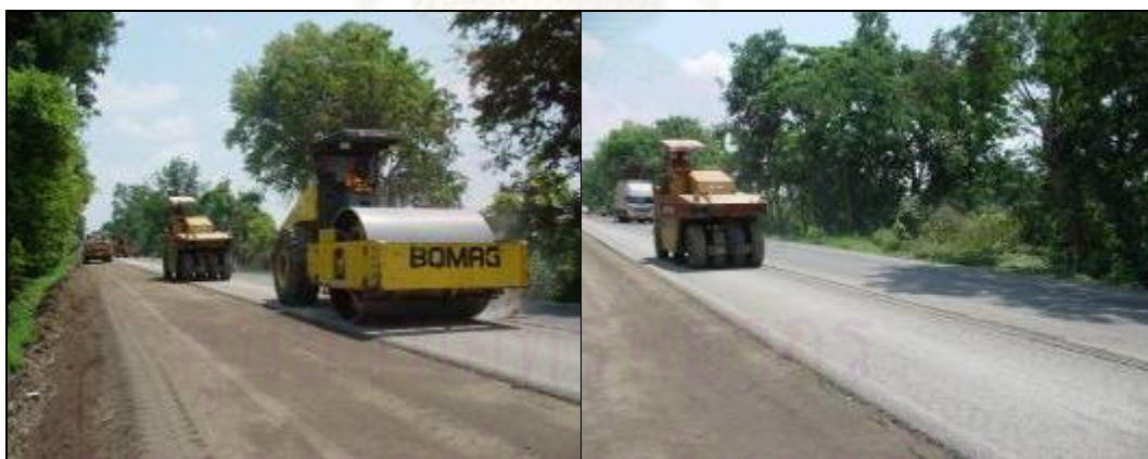
ภาพที่ 4.20 การบดอัดด้วยรถบดล้อยาง น้ำหนัก 12 ตัน
