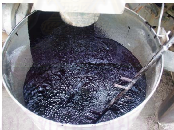
ภาพที่ 4.18 การตรวจสอบคุณลักษณะของโฟมแอสฟัลต์ที่บริเวณหน้างาน
