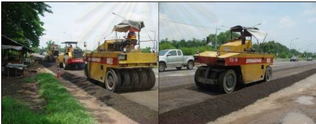
ภาพที่ 4.24 การบดอัดด้วยรถบดล้อยาง น้ำหนัก 12 ตัน
