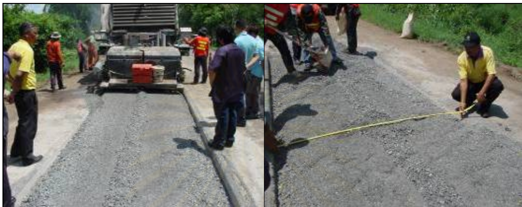
ภาพที่ 4.16 การขุดไสโครงสร้างทางเดิม กว้างครั้งละ 2.20 ม.
