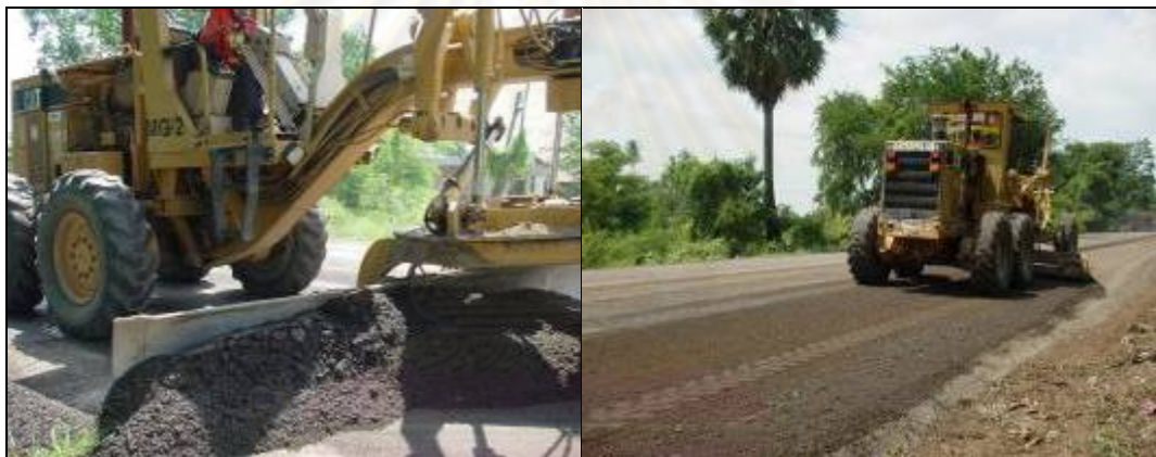
ภาพที่ 4.22 การใช้รถเกรดเกลี่ยปรับระดับและความลาดเอียง
