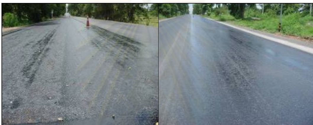
ภาพที่ 4.26 การ Prime Coat ชั้นพื้นทางใหม่
