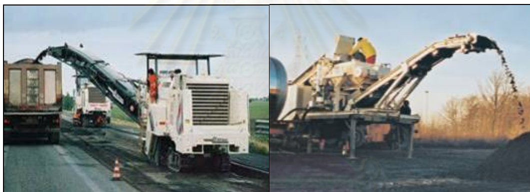
ภาพที่ 2.1 การปรับปรุงคุณภาพแบบผสมที่โรงงาน (In-Plant Recycling)
