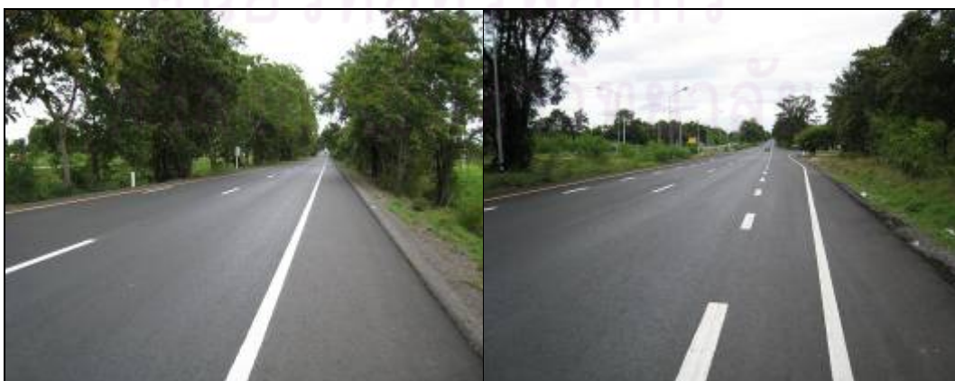
ภาพที่ 4.27 ปูผิวแอสฟัลต์คอนกรีต
