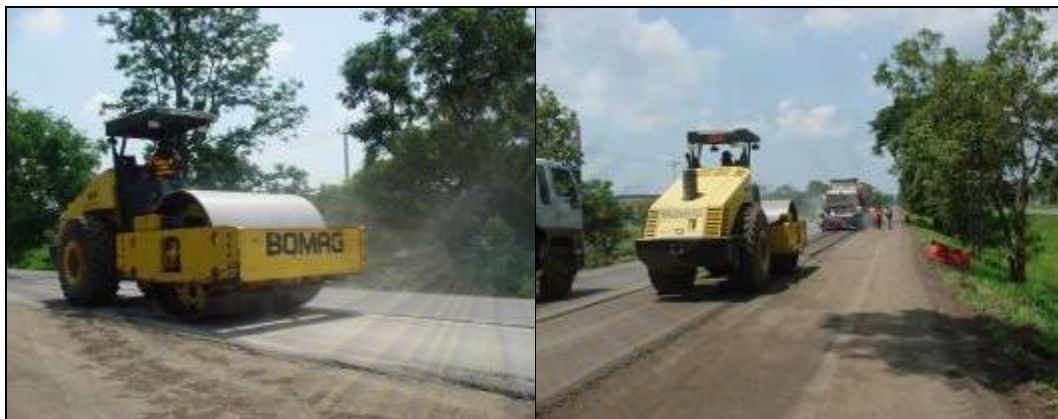
ภาพที่ 4.19 การบดอัดด้วยรถบดล้อเหล็กสันสะเทือน น้ำหนัก 25 ตัน
