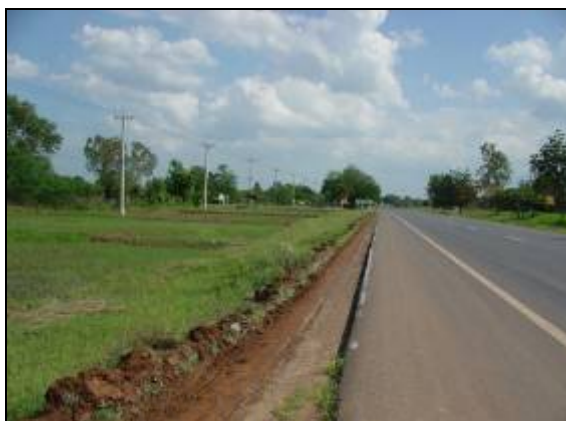
ภาพที่ 4.14 การเตรียมพื้นที่ในการก่อสร้าง (Clearing)
