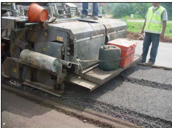
ภาพที่ 4.13 วัสดุโครงสร้างทางเดิมที่ได้รับการปรับปรุงคุณภาพและปูทับโดยเครื่องปูผิว (Paver)
