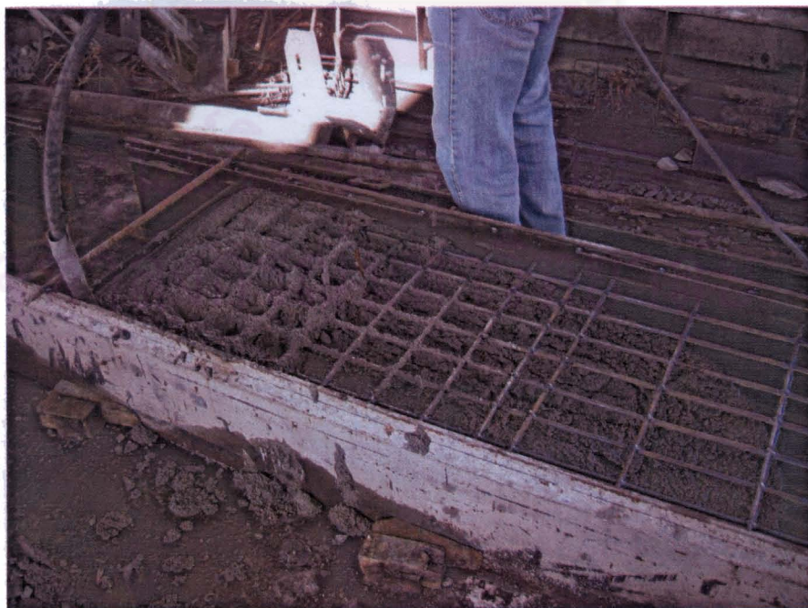
ภาพที่ 8-18 การเทโฟมซีเมนต์ลงในแบบแผ่นพื้น (2)
