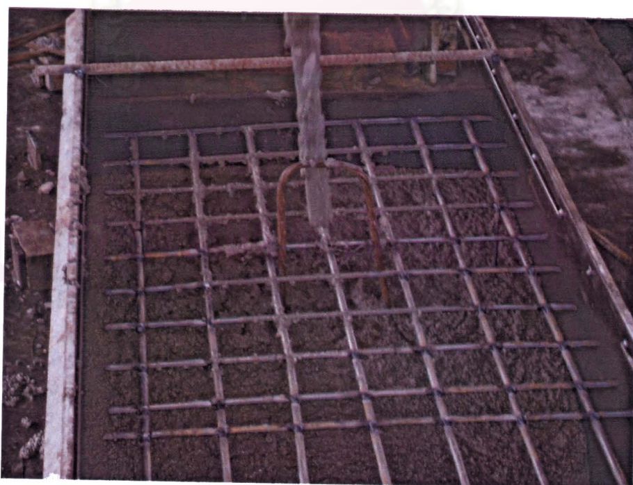
ภาพที่ 8-20 การเทโฟมคอนกรีตลงในแบบแผ่นพื้น (4)
