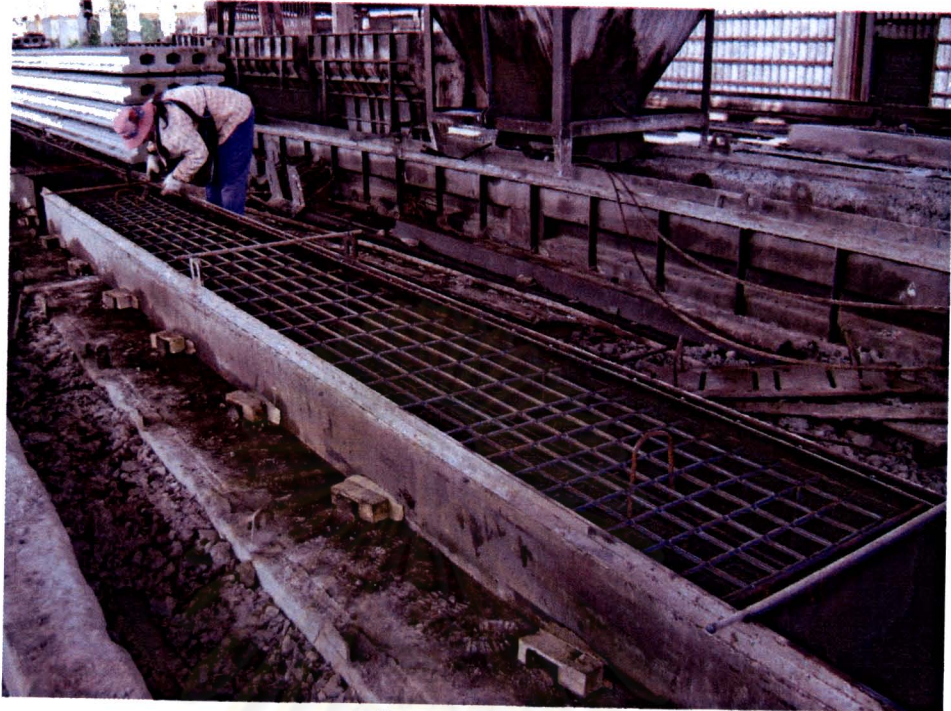
ภาพที่ 8-7 การเตรียมแบบหล่อแผ่นพื้น (2)
