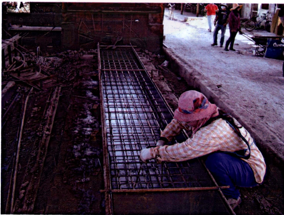
ภาพที่ 8-6 การเตรียมแบบหล่อแผ่นพื้น (1)
