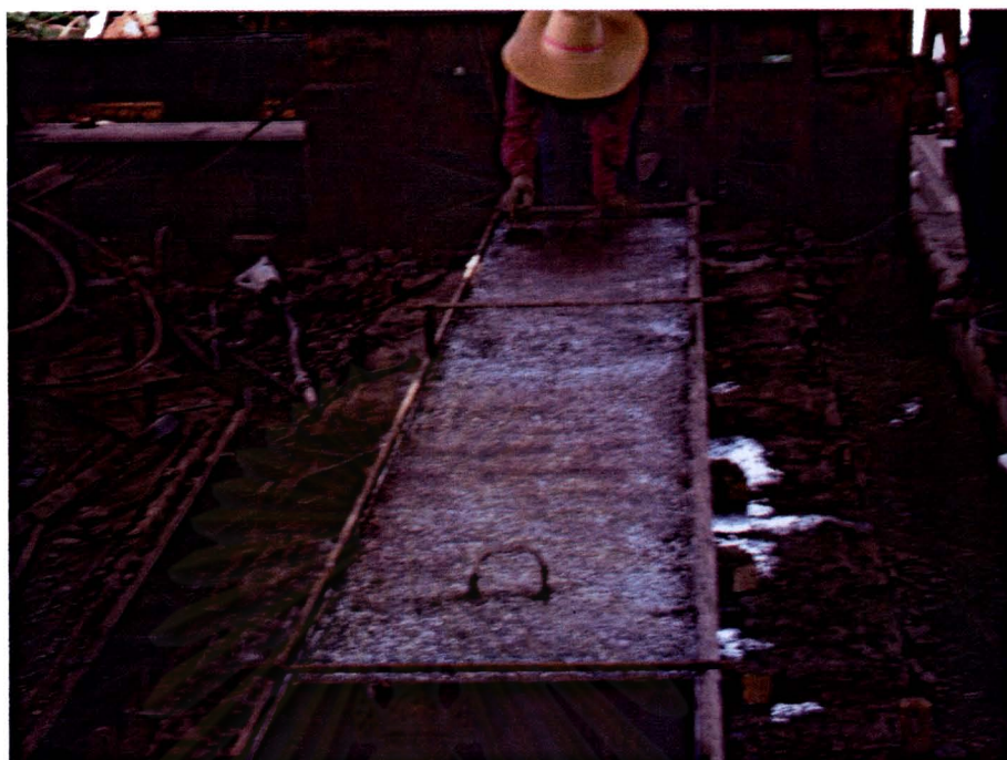
ภาพที่ 8-21 การเทโฟมซีเมนต์ในแบบเสร็จเรียบร้อยและกำลังแต่งผิวหน้า
