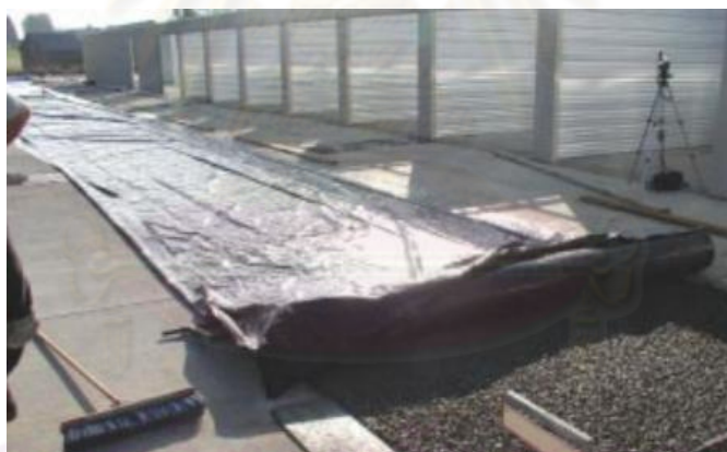
รูปที่ 4.16 การบ่มคอนกรีตด้วยฟิล์มพลาสติกคลุม
