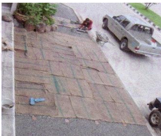
รูปที่ 2.12 การบ่มความชื้นคอนกรีต
