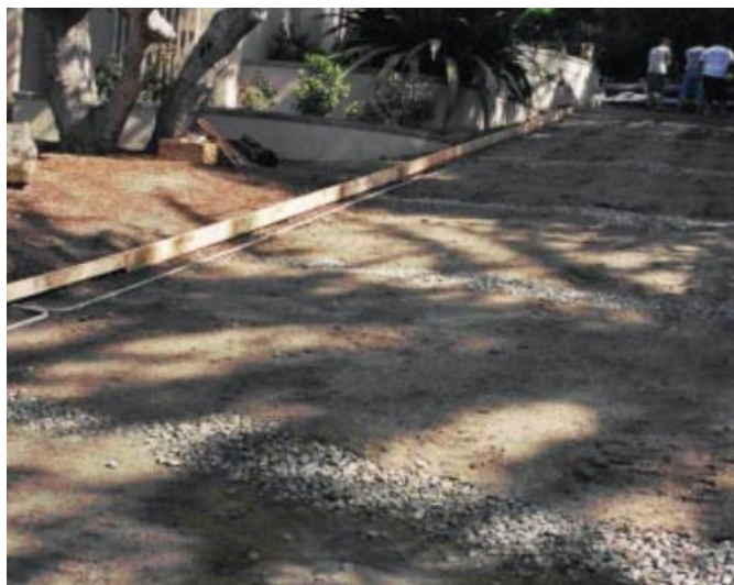
รูปที่ 4.13 การเตรียมดินเพื่อปรับพื้นที่ก่อนเทคอนกรีตพรม
