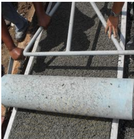
รูปที่ 4.15 การบดอัดคอนกรีตพูนด้วยลูกกลิ้ง
