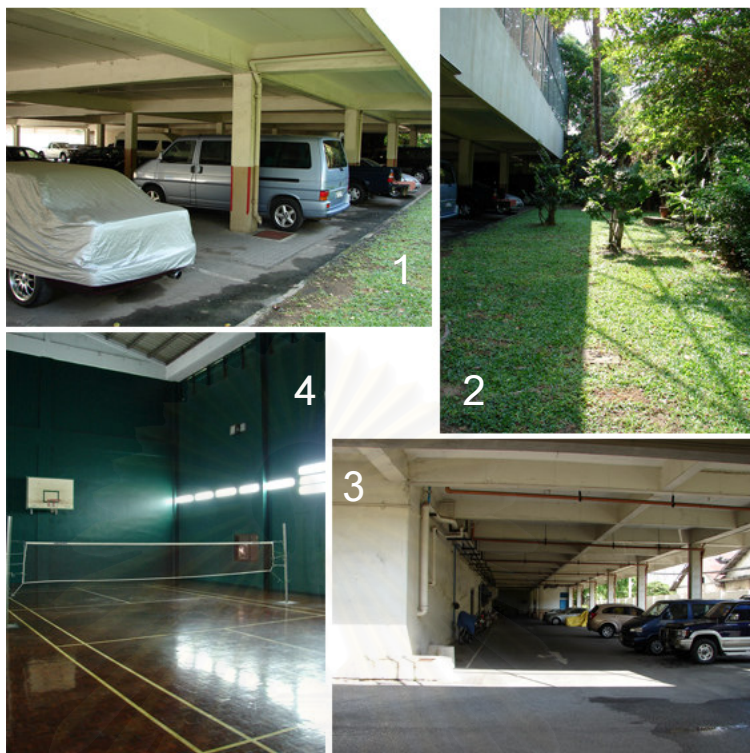
รูปที่ 4.36 แสดงภาพถ่ายโครงการ ริเวอร์เฮาส์ บริเวณชั้นล่าง
