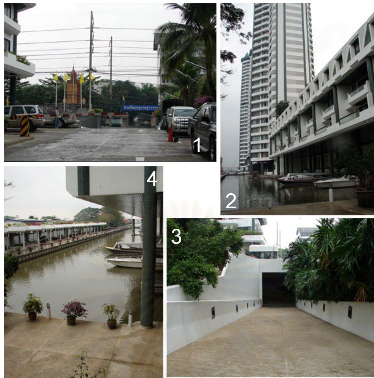
รูปที่ 4.14 แสดงสภาพโครงการบริเวณรอบนอกอาคารชั้นที่ 1
