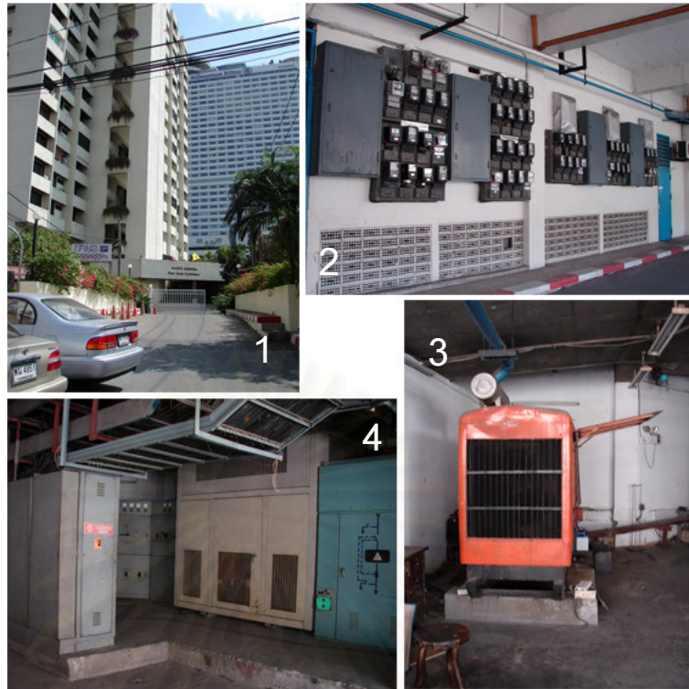
รูปที่ 4.35 แสดงภาพถ่ายโครงการ รีเวอร์เฮาส์ บริเวณชั้นล่าง
