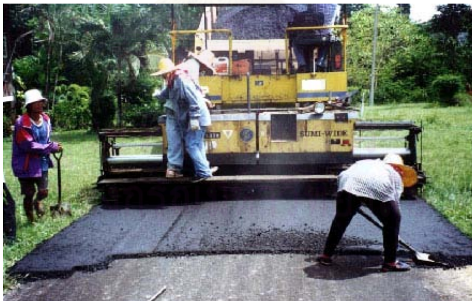
ภาพที่ 2.9 การใช้ยางมะตอยผสมกับยางธรรมชาติปูผิวทาง (วิจิต, 2008)
