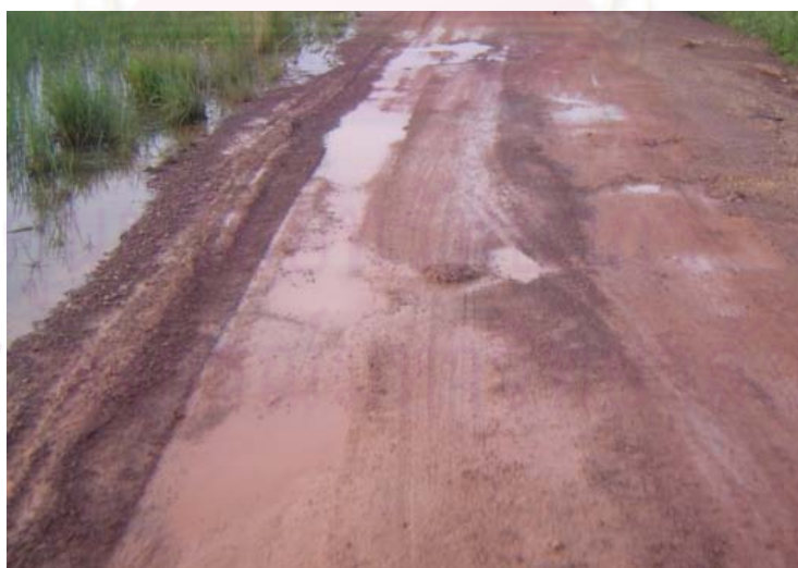
ภาพที่ 2.6 การเกิดร่องล้อเนื่องจากบดอัดไม่แน่น
