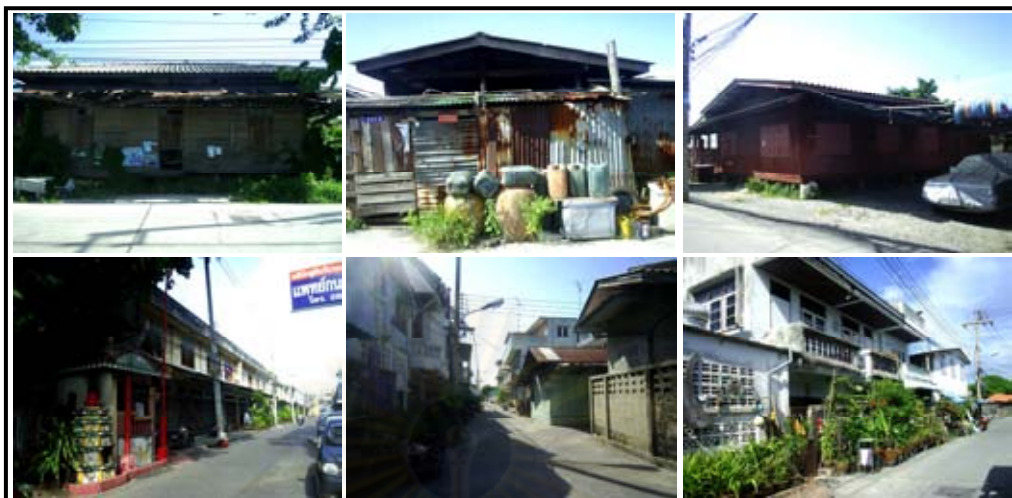
รูปที่ 4.10 สภาพอาคารและสิ่งปลูกสร้างที่มีอยู่ทั่วไปในชุมชน 22
