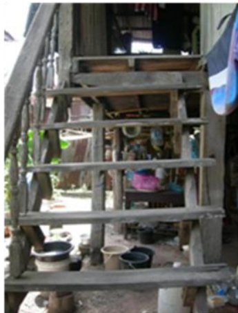
บันไดมีความชันมาก ปัจจุบันผู้พิการไม่ค่อยขึ้นไปใช้ชั้นบน
