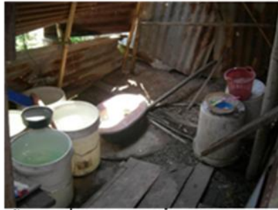
ส่วนแบบนั่งของ ไม่มีผืนกัน และ ไม่ถูกสุขลักษณะ และ ใช้ลำบาก เนื่องจาก รถเข็นเข้าไม่ได้
