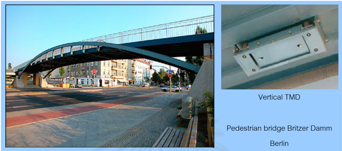
รูปที่ 2.21 สะพาน Pedestrian bridge Britzer Damm Berlin /Germany
