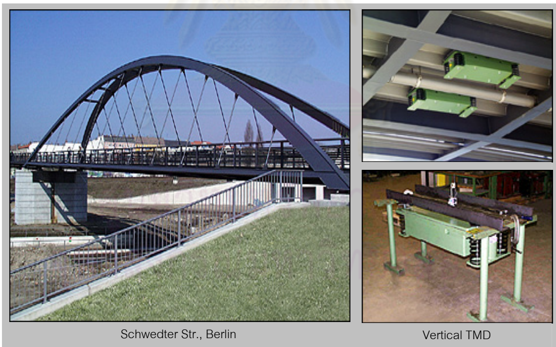
รูปที่ 2.20 สะพาน Schwedter Str., Bridge, Berlin/Germany
