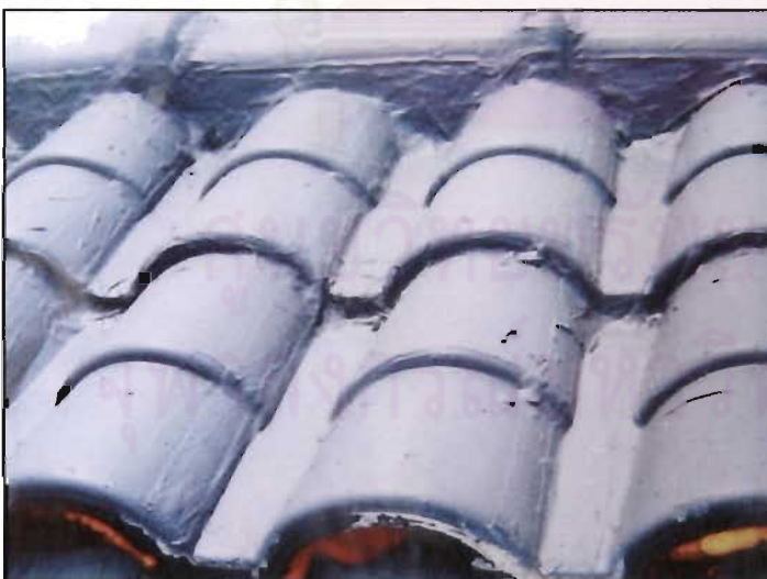
ภาพที่ 2-8 แสดงปัญหาจากการเลือกชนิดฉนวนไม่เหมาะสม
