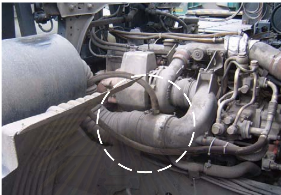
รูปที่ 4-51 แสดงภาพอุปกรณ์ผสมก๊าซกับอากาศที่ติดตั้งในรถหัวลาก Hino รุ่น FM2PKPA
