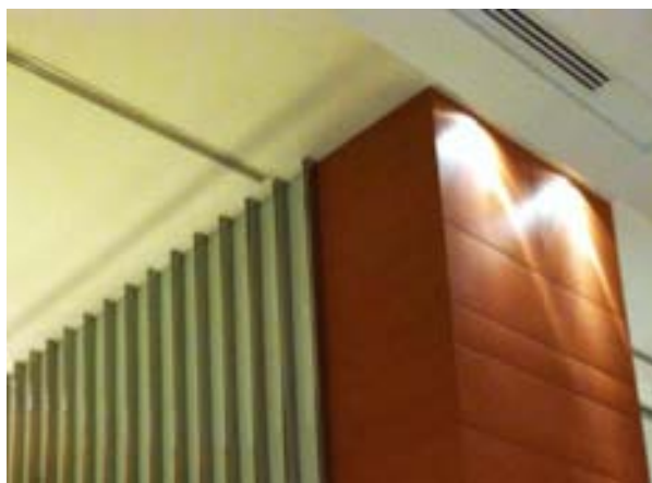
ภาพที่ 2.12 แสดงตัวอย่างการใช้ไฟแบบ Wallwashing ในอาคารประเภทโรงแรม
