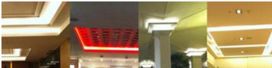
ภาพที่ 5.19 ตัวอย่างไฟแบบ Cove Lighting ที่ปรากฏในกรณีศึกษา
