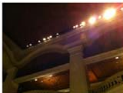
ภาพที่ 2.9 แสดงตัวอย่างการใช้ไฟแบบ Downlight ในอาคารประเภทโรงแรม
