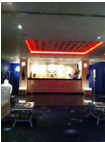
ภาพที่ 2.11 แสดงตัวอย่างการใช้ไฟแบบ Cove Lighting ในอาคารประเภทโรงแรม
