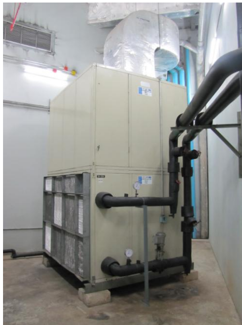
ภาพที่ 3.12 Packaged Air Unit
