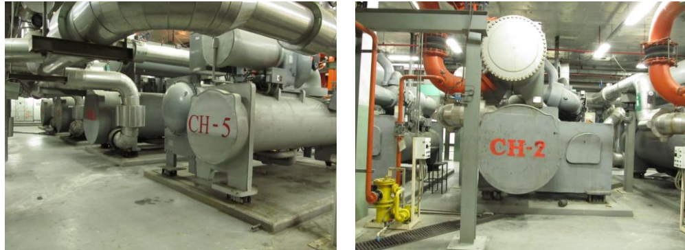
ภาพที่ 3.4 เครื่องทำน้ำเย็น (Water Chiller)
