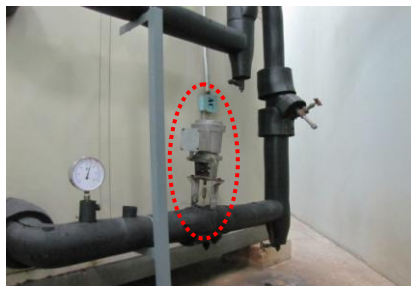
ภาพที่ 3.52 Motorize Valve
