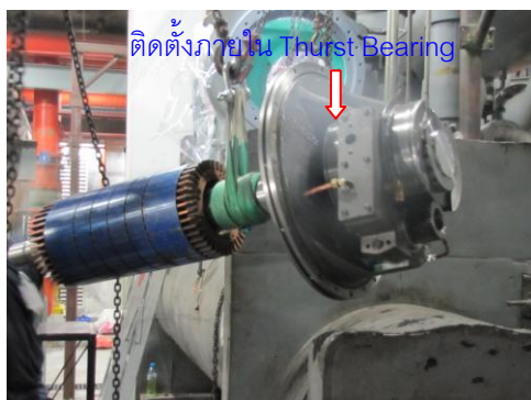
ภาพที่ 3.31 Thrust Bearing Temperature Sensor
