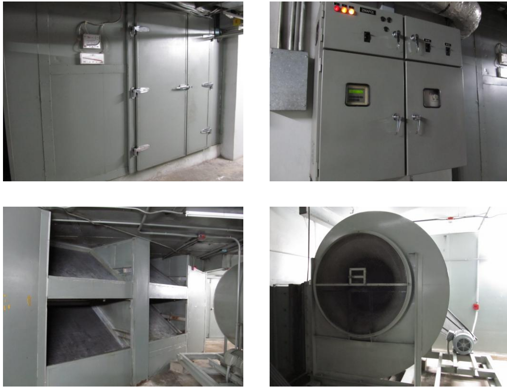
ภาพที่ 3.13 Built up Air Unit
