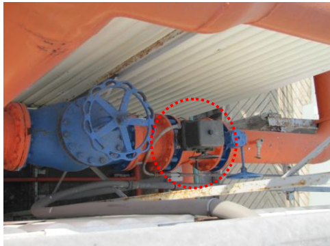
ภาพที่ 3.49 Motorize Valve
