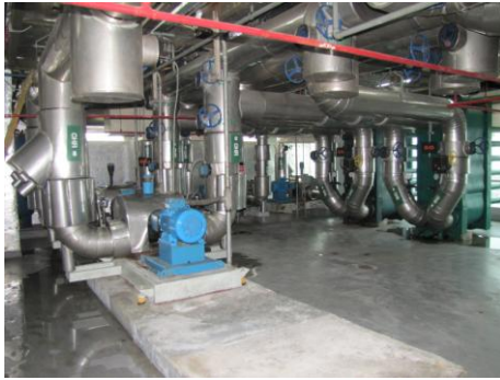
ภาพที่ 3.8 Heat Exchangers Pump - HXP
