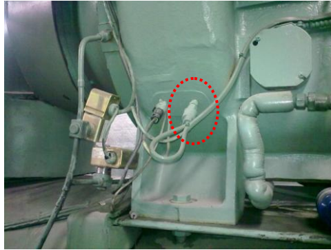
ภาพที่ 3.27 Oil Pressure Transducer & Cable Error
