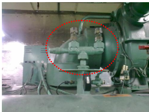
ภาพที่ 3.23 Pressure Relief Valve
