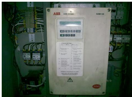
ภาพที่ 3.53 Variable Air Volume (VSD)
