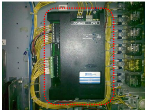
ภาพที่ 3.36 Starter Management Module (SMM) Error
