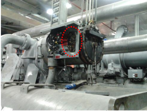
ภาพที่ 3.24 การรั่วของสารทำความเย็นที่ Terminal Compressor
