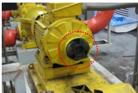
ภาพที่ 3.45 Rubber Joint
