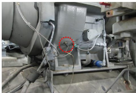
ภาพที่ 3.26 Discharge Temperature Sensor Error
