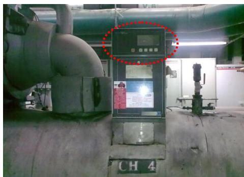
ภาพที่ 3.37 Local Interface Display Control Panel (LID) ไม่แสดงผล
