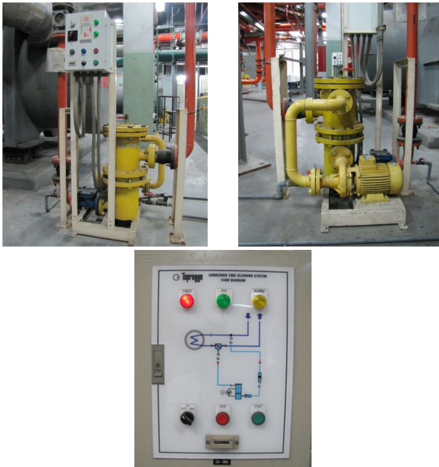
ภาพที่ 3.10 ระบบล้างตะกอนในชุดหล่อเย็นอัตโนมัติ (Ball Cleaning)
