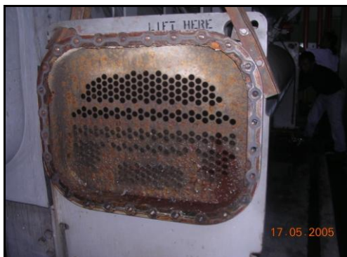
ภาพที่ 3.20 การอุดตันของ Tube ใน Condenser
