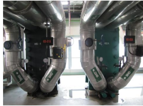
ภาพที่ 3.8 Heat Exchangers Pump - HXP
