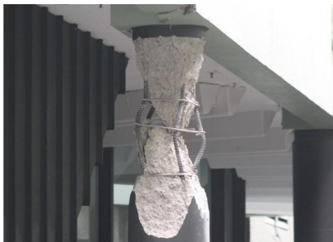
ภาพที่ 1.1 การโก่งเดาะของเหล็กเสริมตามยาวบริเวณจุดหมุนพลาสติก
