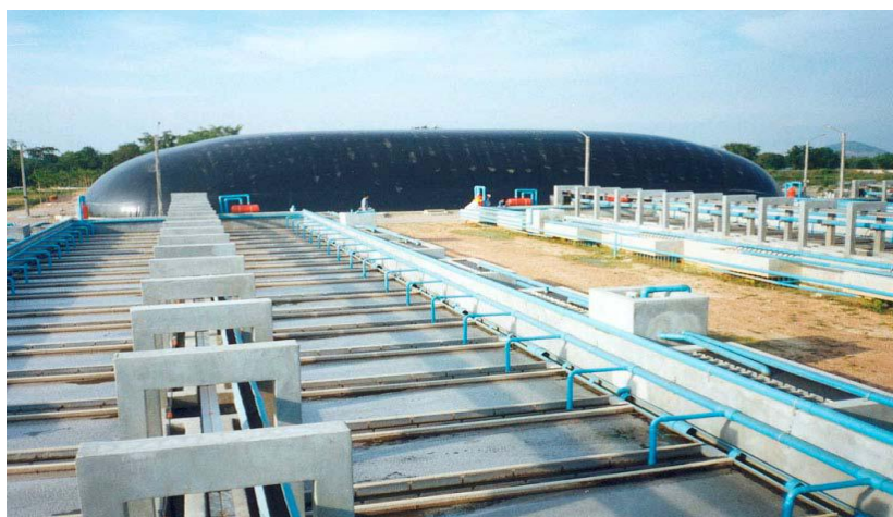
ภาพผนวกที่ ง-5: ตัวอย่างภาพประกอบลานตากตะกอน (Sludge Drying Bed)
