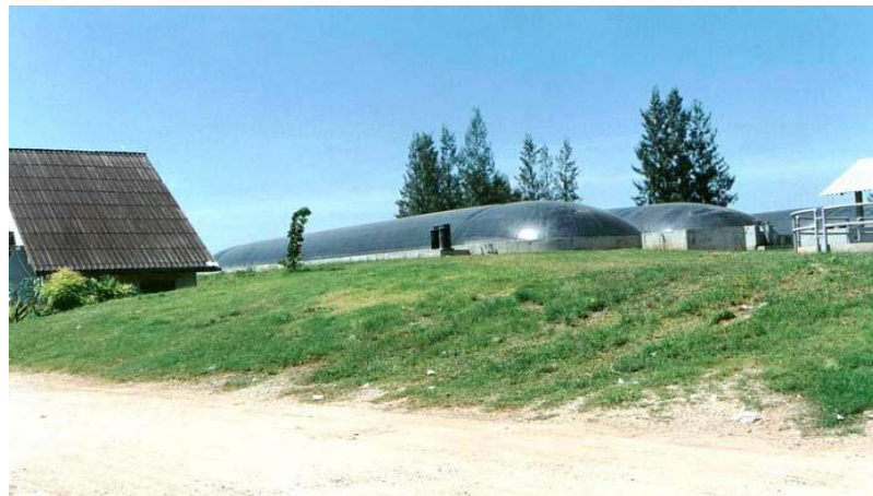
ภาพผนวกที่ ง-4: ตัวอย่างภาพประกอบบ่อบำบัดแบบราง (Channel Digester) : ก๊าซชีวภาพถูกจัดเก็บไว้ ใต้ผืนผ้าใบ
