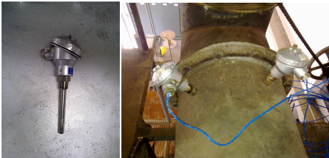
ภาพที่ 5.1 เทอร์โมคัปเปิลชนิด K
