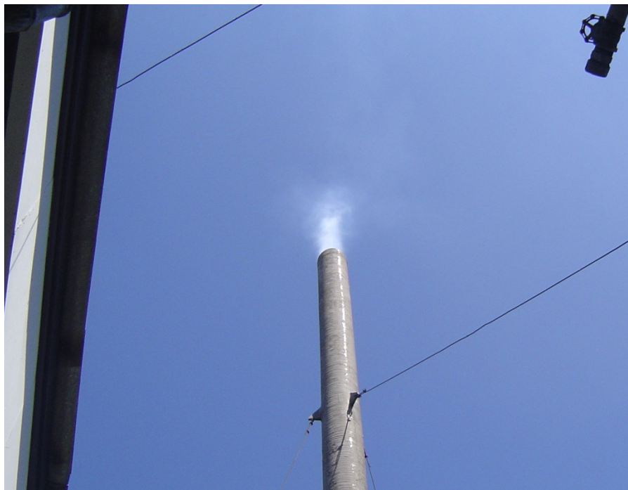
ภาพที่ 6.8 รูปถ่ายแสดงสภาพไอเสียที่ปล่อยทิ้งทางปล่องระบายในขณะที่ป้อนมูลฝอยหลังจากที่ติดตั้งอุปกรณ์อุ่นอากาศแล้ว (วันที่ 8 ก.ค. 54)
