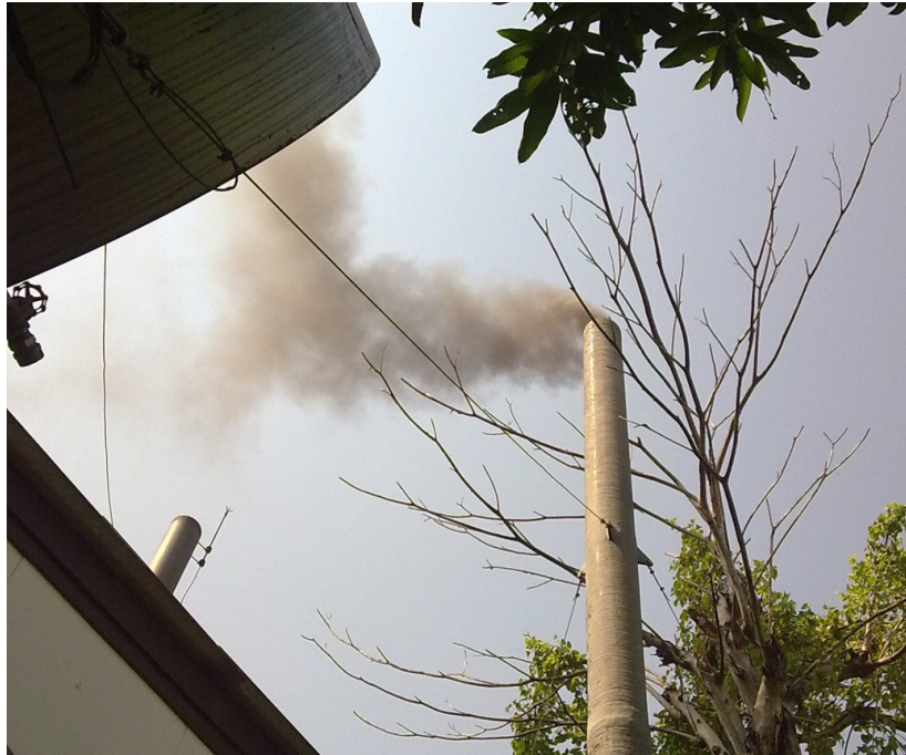
ภาพที่ 6.7 รูปถ่ายแสดงสภาพไอเสียที่ปล่อยทิ้งทางปล่องระบายในขณะที่ป้อนมูลฝอยก่อนการติดตั้งอุปกรณ์อุ่นอากาศ (5 พ.ย. 53)
