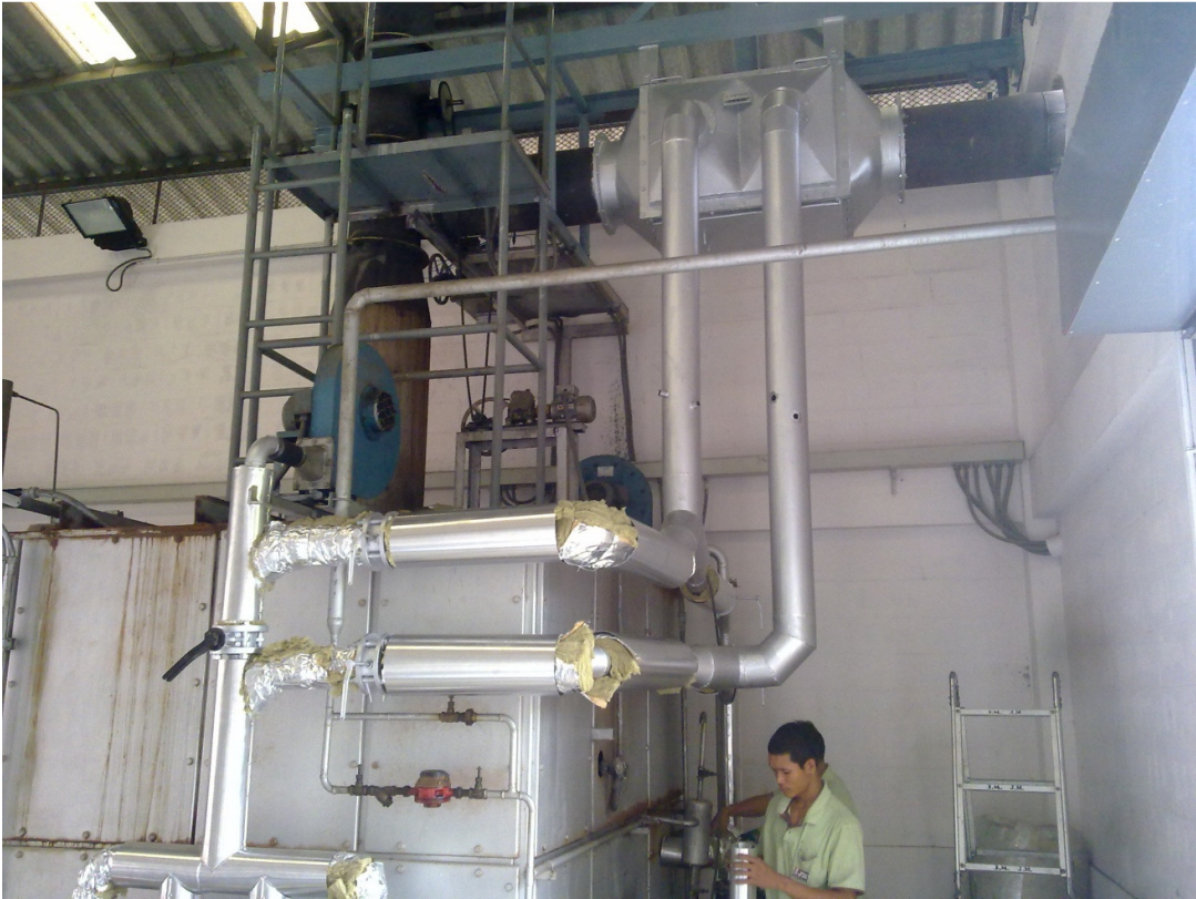
ภาพที่ 4.8 ทำการติดตั้งเครื่องอุ่นอากาศที่บริเวณปล่องไอเสีย และติดตั้งท่อลมโดยใช้ใยหินเป็นฉนวนหุ้มท่อลม
