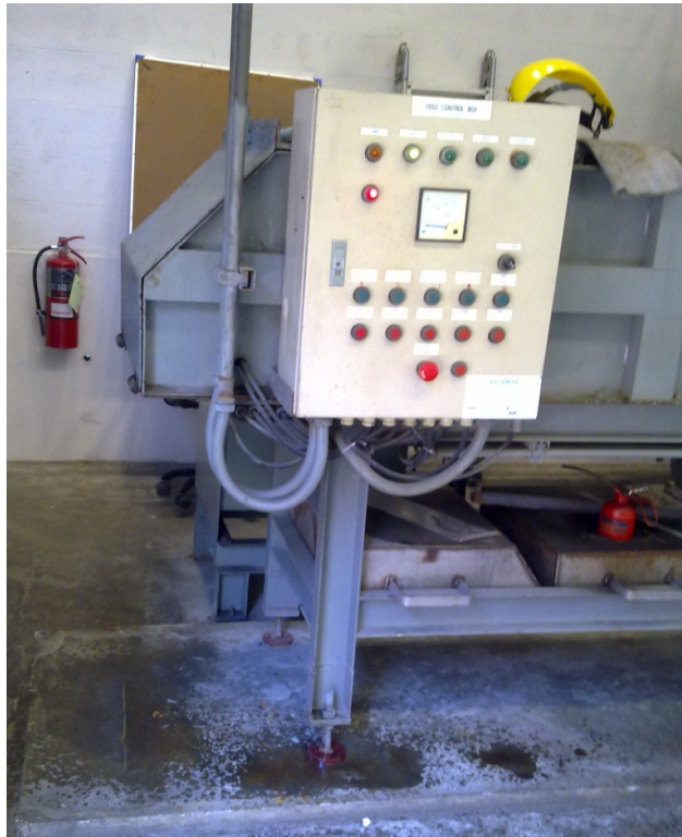
ภาพที่ 5.8 แผงควบคุมการทำงานของชุดอุปกรณ์ป้อนมูลฝอยเข้าสู่เตาเผามูลฝอยติดเชื้อ
