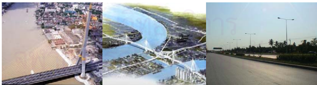
ภาพประกอบ4.55 ระบบสาธารณูปโภคของมหานครที่จะรวมเอาสองฝั่งแม่น้ำเข้าด้วยกัน
