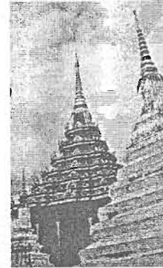
ภาพที่ 3.121 พระมณฑปเครื่องยอดเครื่องคอนกรีต
