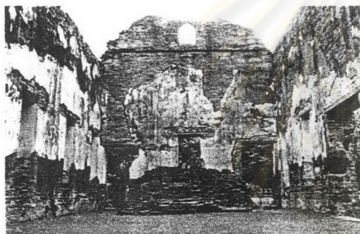
ภาพที่ 3.13 ภายในอาคารไม่มีเสาร่วมใน และมีการทำซุ้มทรงพนมบริเวณหน้าบัน
