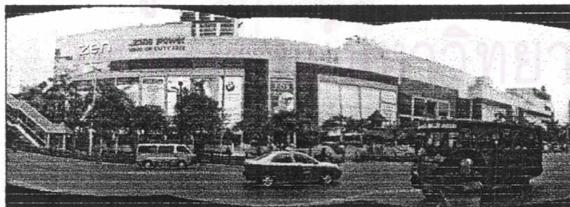
4.อาคารห้างสรรพสินค้า เซ็นทรัลเวิลด์ ทลาซ่า ที่มีรูปแบบเรียบง่าย แต่แสดงความทันสมัยด้วยวัสดุ เป็นอาคารขนาดใหญ่ที่ถอยร่นอาคารลึก เกิดลานกิจกรรมขนาดใหญ่ เป็นจุดเด่นของอาคาร
